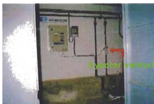
Figura 5.5 Instalación del ozonizador NEPTUNO V en el hospital Infanta Elena, Badajoz España.
