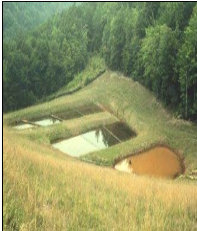
Figura N° 6.1 Pantanos Anaerobios (Brix, 1993 y USEPA, 2000)
