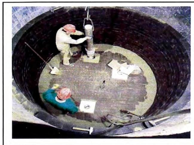
**Figura N°23:** Reparación de las paredes de la cuchara.
