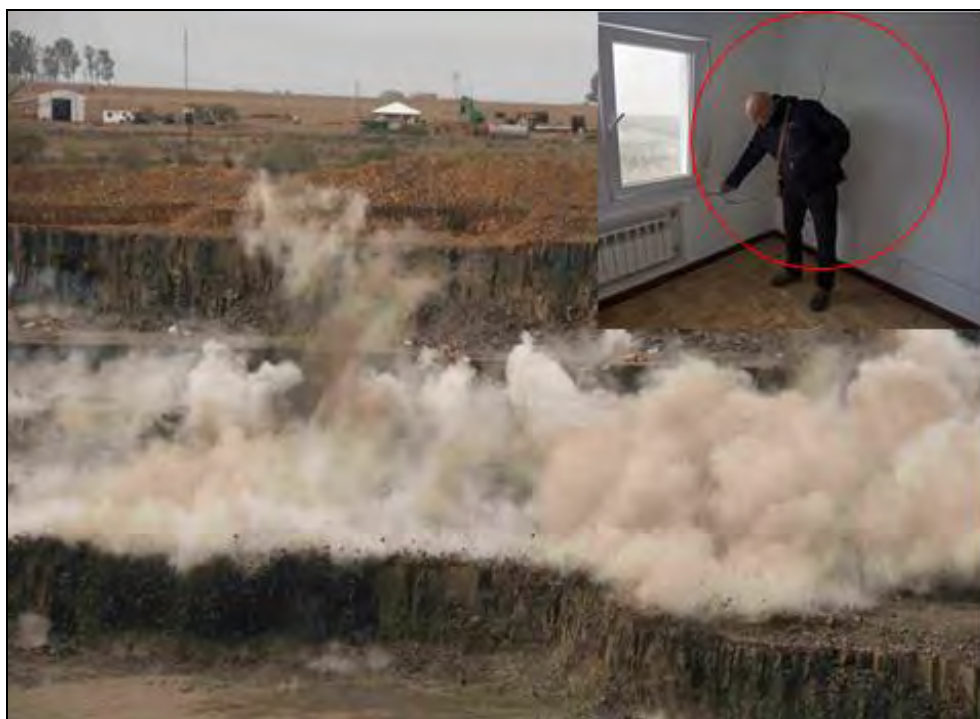
Figura N° 6.1: Muestra el daño a las estructuras por las vibraciones inducidas por la voladura de rocas. Fuente: Yeison Peña Vizarreta
