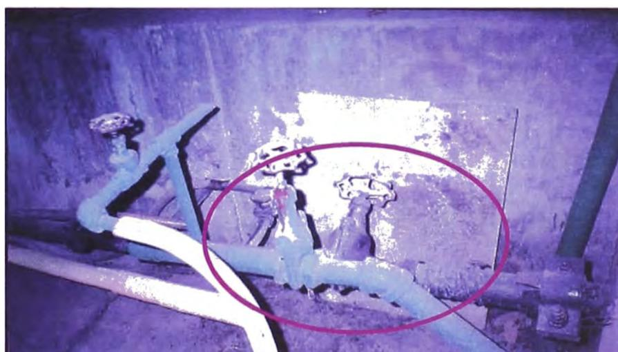
**Figura 2.32 Fuga de la tubería del cuarto de mezcla de reactivos**
