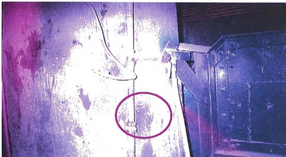
**Figura 2.33 Fuga de la tubería de las tolvas - Ventanas en concentradora**
