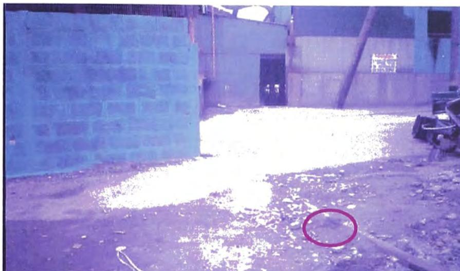
**Figura 2.31 Fuga de la tubería de distribución del deposito de reactivos**
