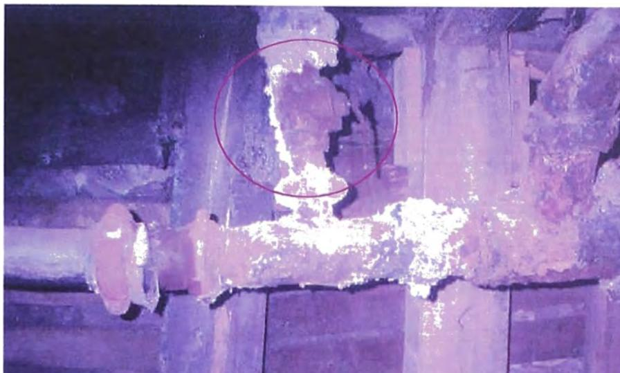
**Figura 2.37 Fuga en la válvula de la mina subterránea del nivel 1200 – Galería 12016**
