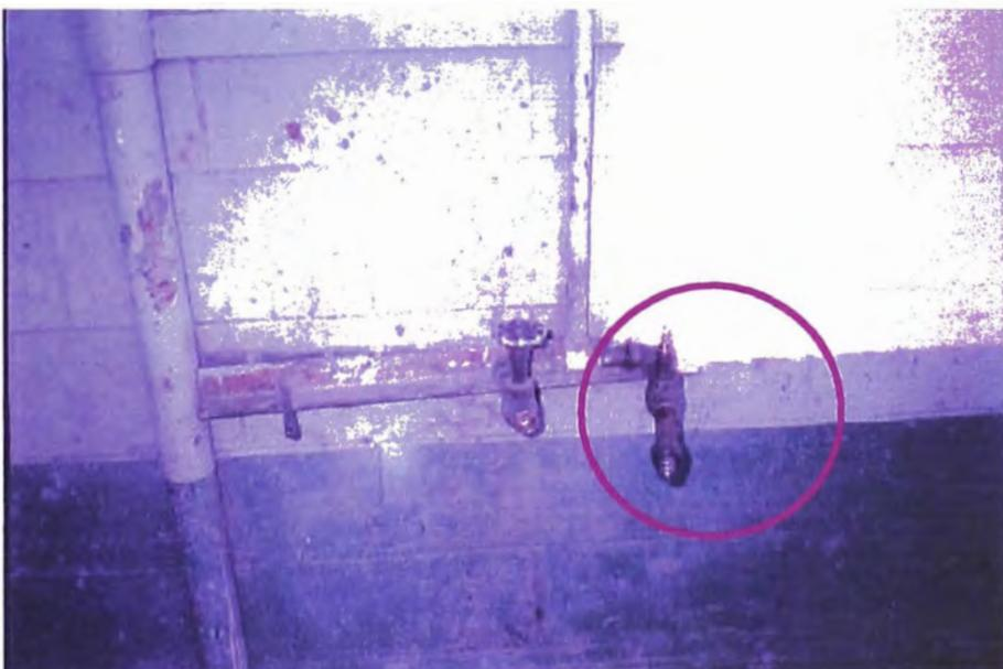
**Figura 2.30 Fuga de la válvula de distribución en el taller eléctrico superficie**
