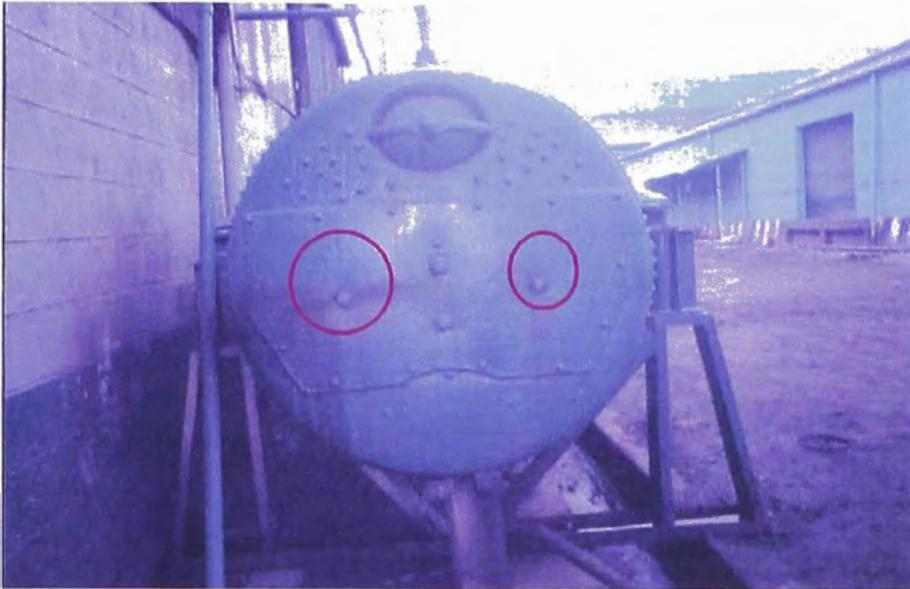
**Figura 2.29 Fuga del tanque acumulador en el taller de mastranza**
