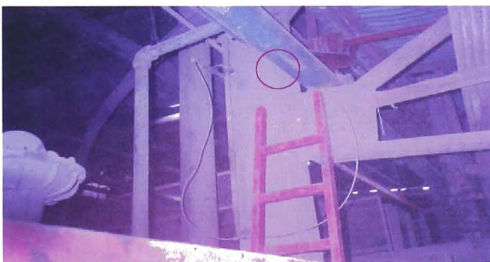
**Figura 2.34 Fuga de la tubería de los bancos de flotación de zinc**
