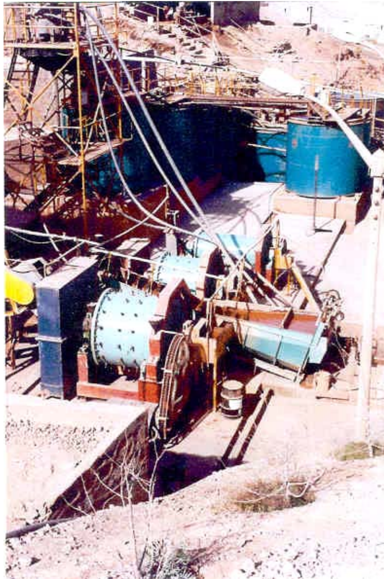
Foto N° 16: Vista de la planta concentradora
