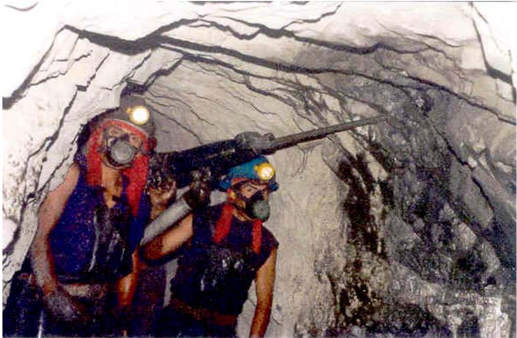
Foto N° 12: Trabajo en interior mina
