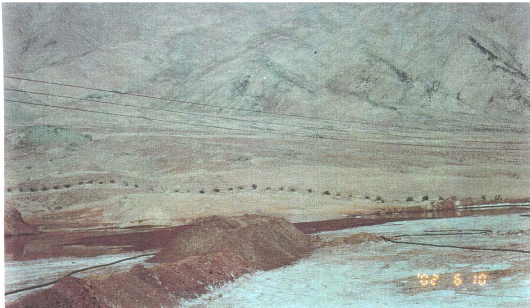
Foto N° 30: Se esta sembrando de huaranguillo alrededor de la relavera
