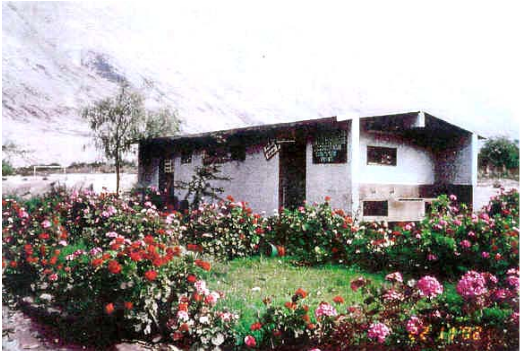
Foto N° 32: Vista de los servicios higiénicos en planta
