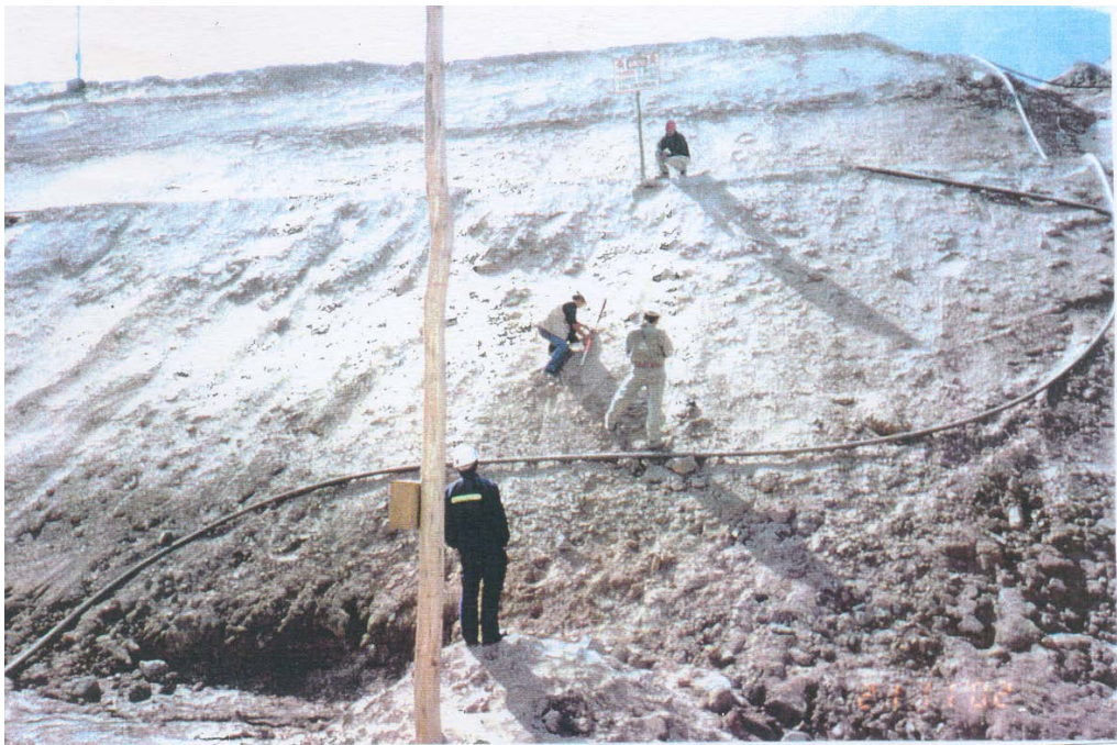
Foto N° 26: Medición en el talud de la relavera
