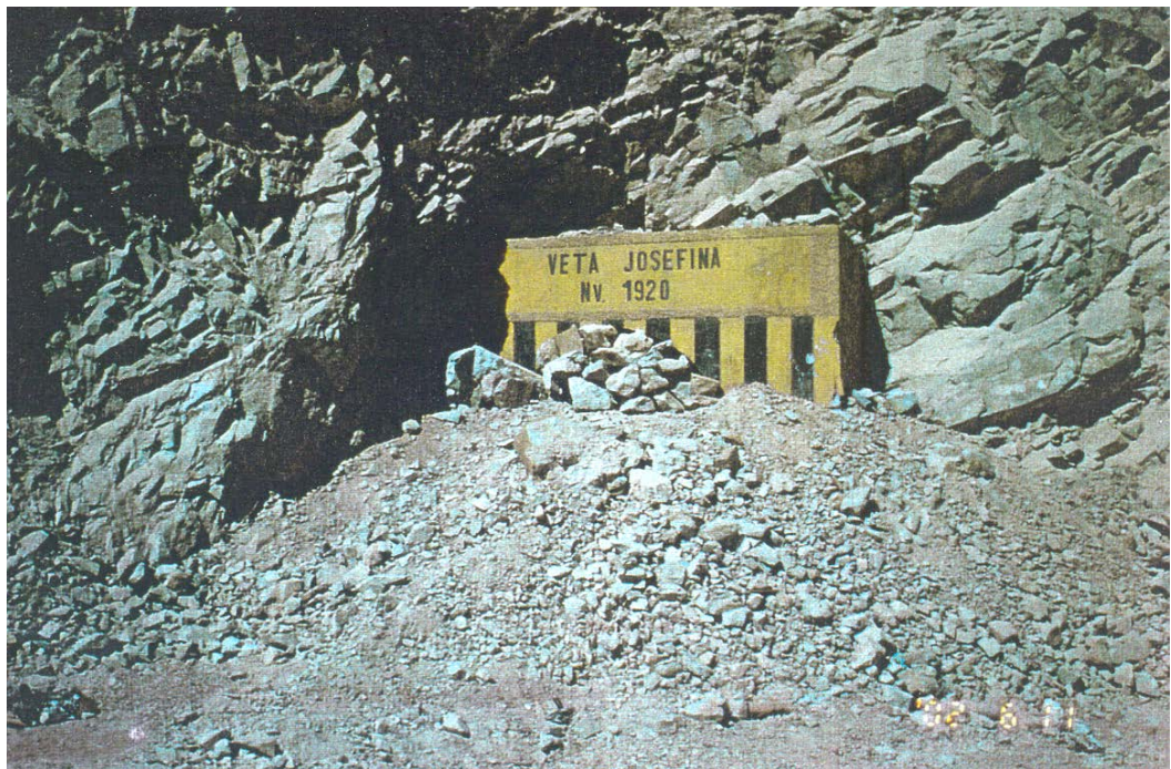
Foto N° 13: La bocamina serán taponeadas
