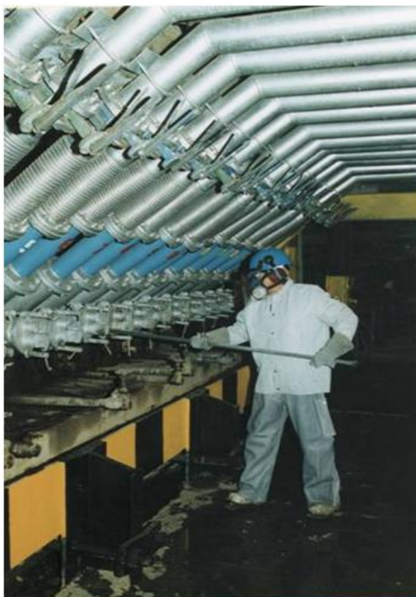
Foto N° 4-9. Ingreso de aire al horno de plomo
