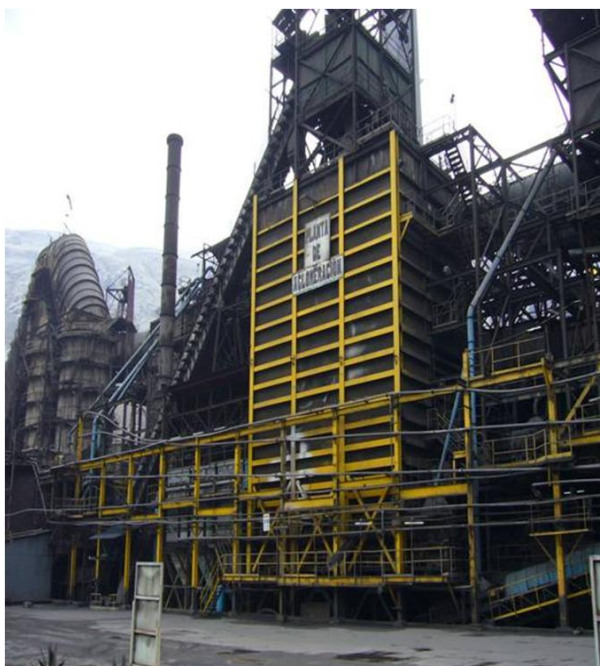
Foto N° 4-1. Vista de la planta de aglomeración
