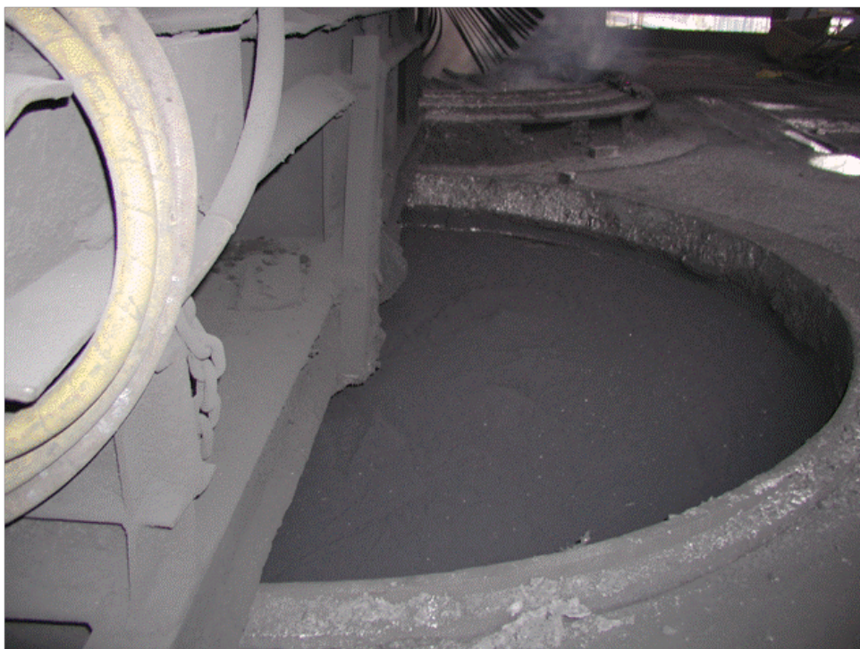
Foto N° 4-15. Polvo formado en el decoperizado
