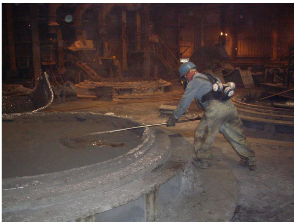
Foto N° 4-15. Limpieza del polvo formado con el decoperizado
