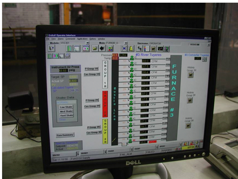
Foto N° 4-7. Vista de los controles del horno 3
