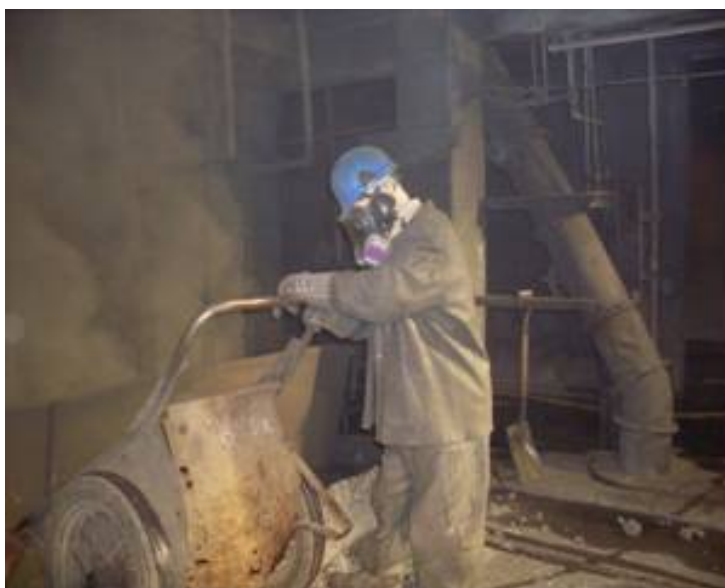
Foto N° 4-10. Alimentación de chatarra al horno de plomo.
