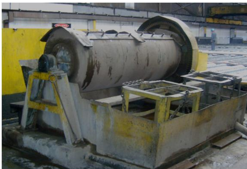
Foto N° 4-24. Maquina lavadora de varillas de cobre
