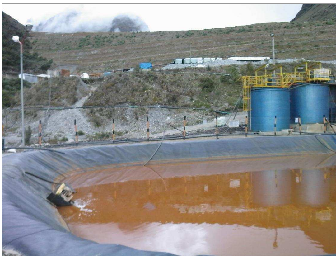
FIGURA 26. Bombeo de la solución clarificada a hacia la etapa de oxidación.
