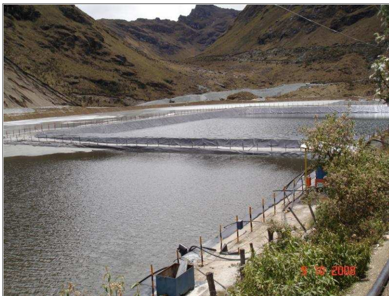
FIGURA 5. Relavera de cianuración # 3 y bomba de recirculación.
