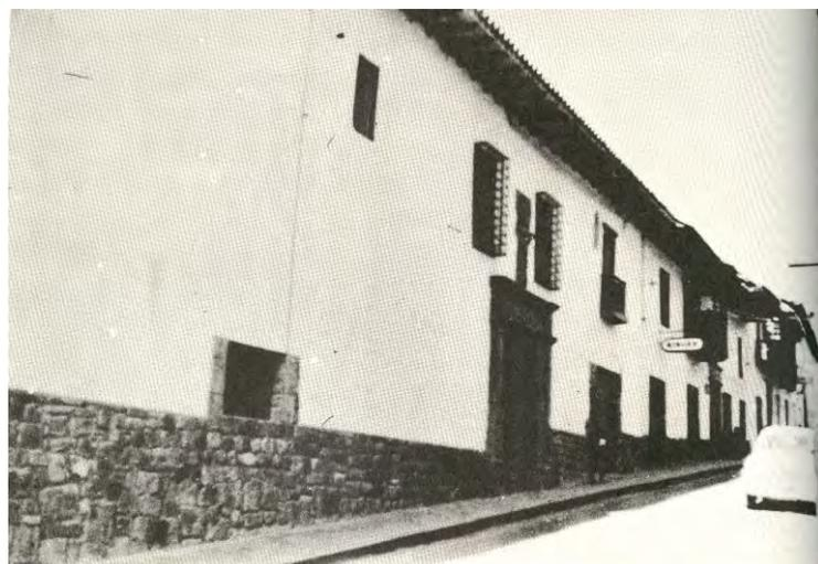
Figura N ° 06a.- Edificación Colonial en adobe, obsérvese la altura del muro de adobe.
