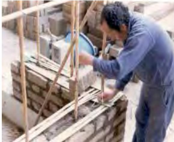
Figura N ° 63.- Colocación del Refuerzo de Caña en Perú.
