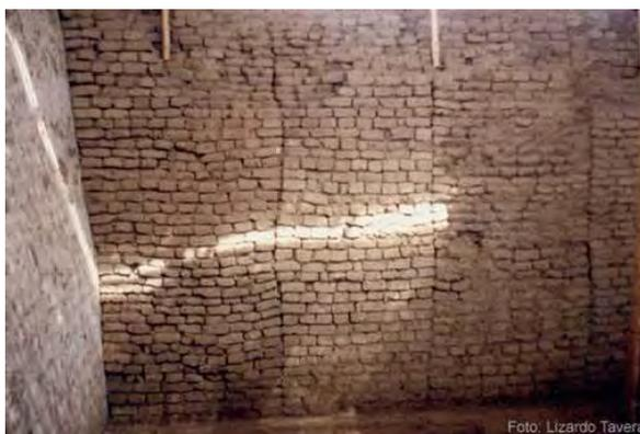
La otra técnica utilizada para la construcción de las grandes edificaciones monumentales, fue la de los paneles o bloques modulares de adobes, esto implicó el empleo de más tiempo y esfuerzo en la fabricación de adobes y en la misma construcción. Para construir las
