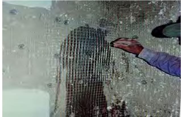
Figura N ° 69.- Instalación de conectores y geomalla
