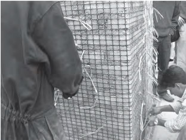
Figura N ° 70.- Fijación de malla de polipropileno, en el muro con conectores.
