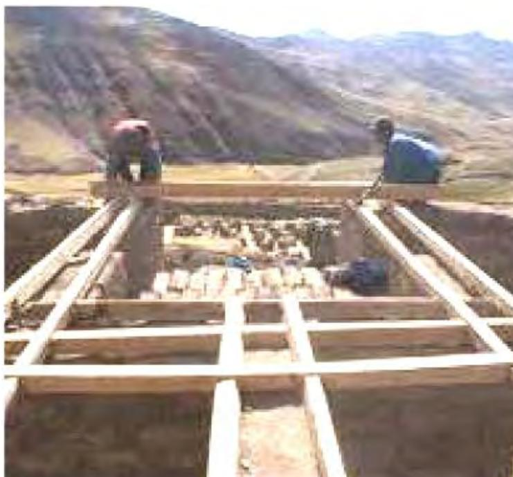
Figura N ° 85. Colocación de viga solera
