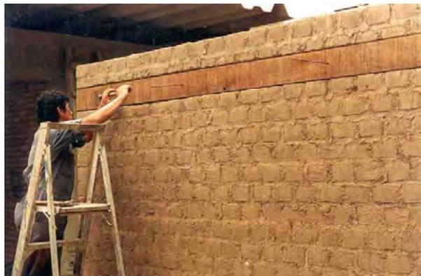
Figura N ° 88. Muro de adobe reforzado con sogas      Figura N ° 89. Muro de adobe reforzado con tabla.
