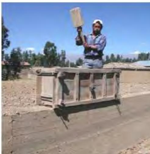
Figura N° 50. - Encofrado, colocación, y compactación de un muro de tapial
