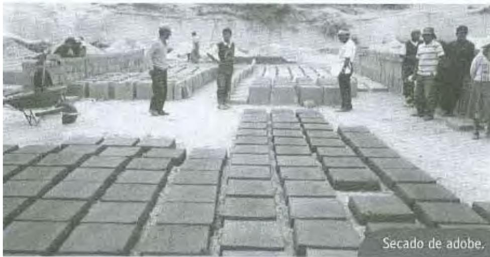
Figura N ° 75. Se muestra el tendal y el proceso de secado de adobes.
