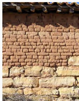
Figura N °10.-Muro de adobe sobre basamento de piedra
