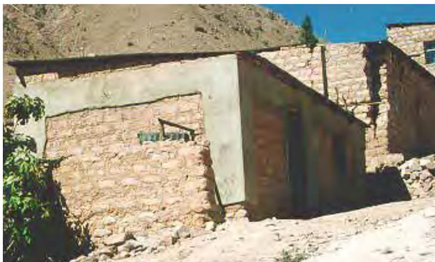
Figura N ° 65: Viviendas existentes reforzadas en 1998 en Moquegua (sur de Perú), después del sismo del 2001.
