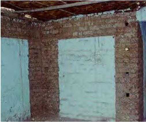
Figura N ° 68. - Eliminación del tarrajeo, luego se perfora el muro, para colocar los conectores
