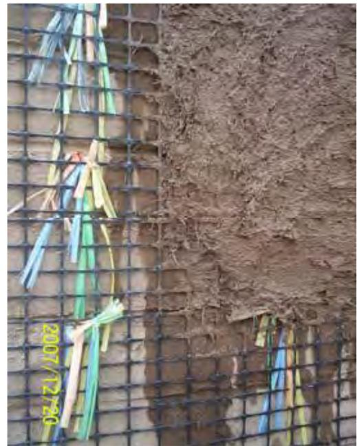
Figura N ° 71.- Detalle revoque muro con barro encima de geomalla.
