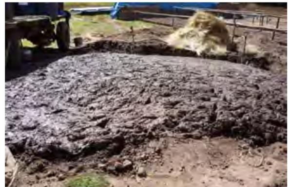
Figura. N ° 72.- Mezclado de barro.
