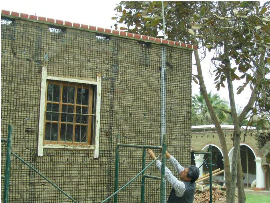
Figura N° 87. Colocación de malla de polipropileno o geomallas
