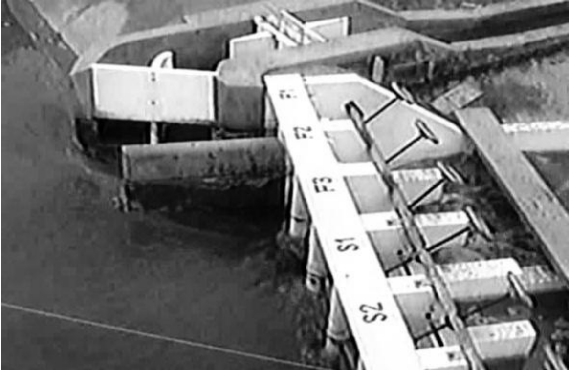
Fotografía 5.5. Descarga con flujo presurizado
