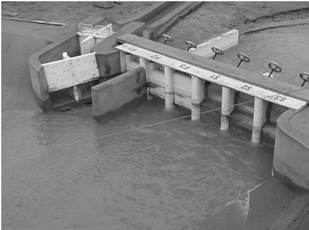
Fotografía 5.13.- Evacuación de sedimentos primeras tres horas
