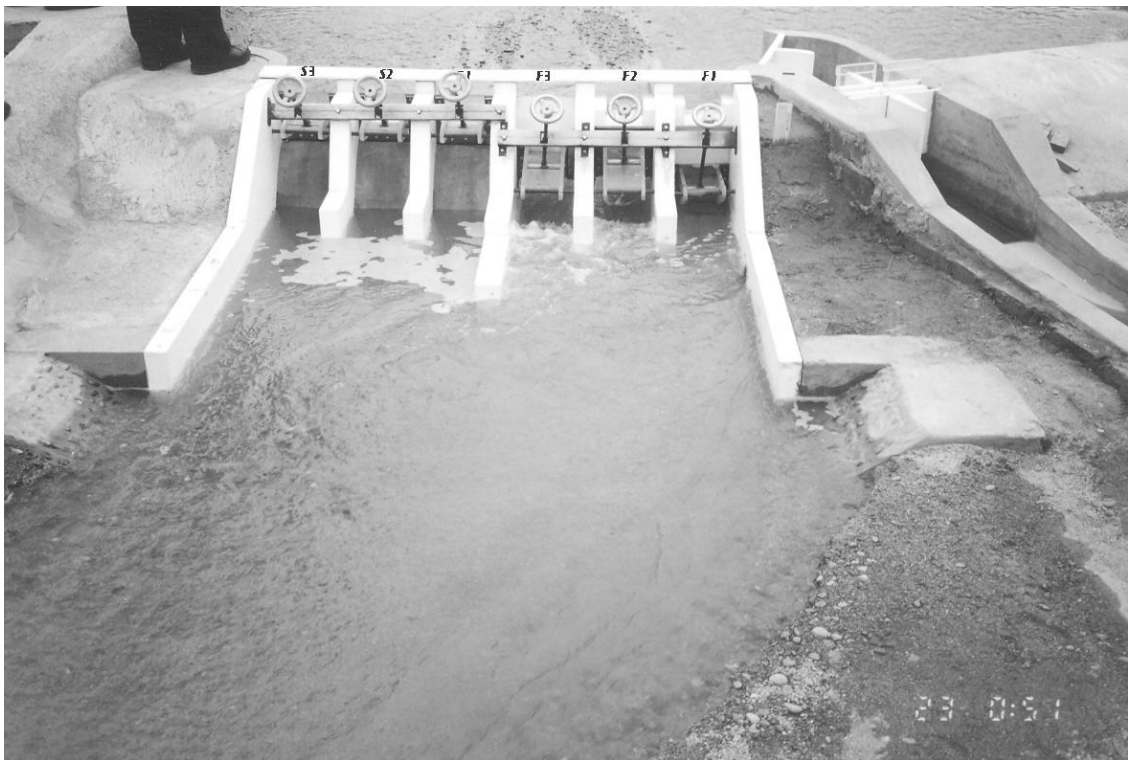
Fotografía 5.10. Descarga de flujo con sedimentos a través de las compuertas de fondo
