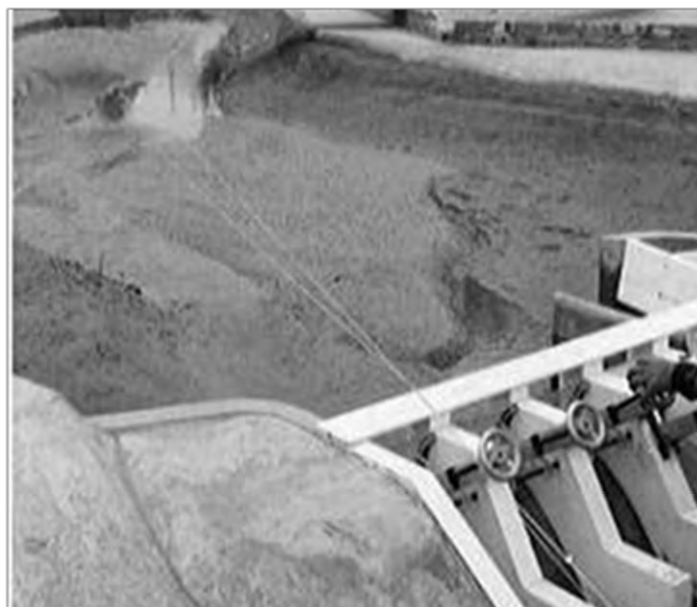
Fotografía 5.2. Avance de la barra de sedimentación en el embalse
