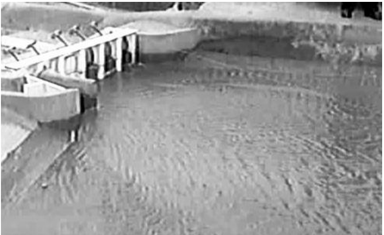
Fotografía 5.8. El caudal de salida es igual al caudal de ingreso y se tiene flujo con superficie libre
