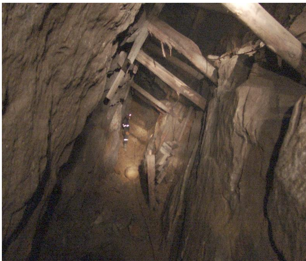
Foto N° 16.- Sostenimiento del tajeo con puntales caja a caja.
