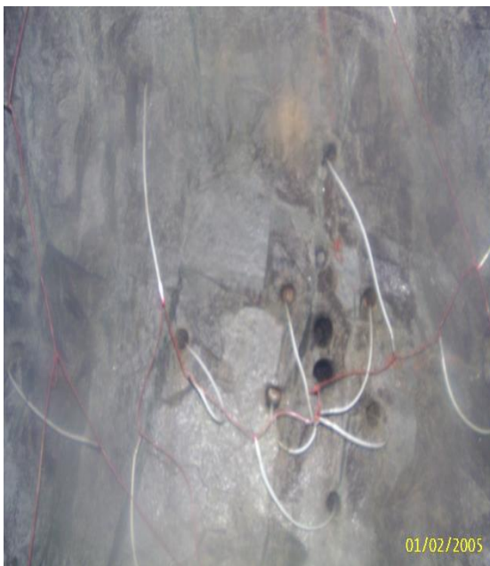
Marcado de Mallas y perforación de frentes
