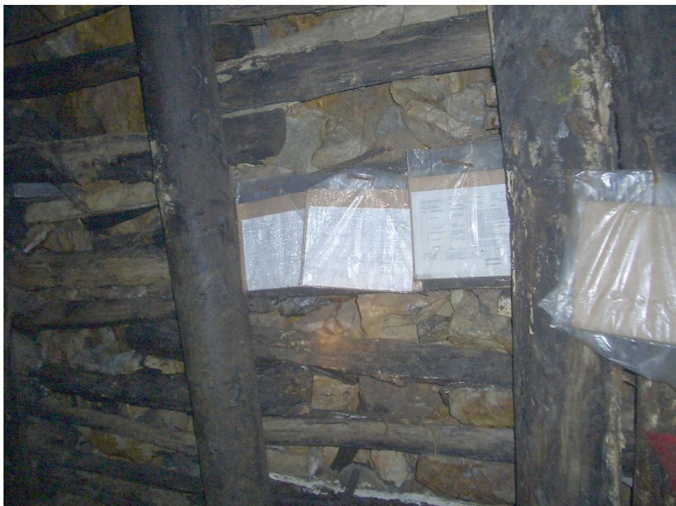
Foto N° 15.-Tableros de la Supervisión indicando las medidas correctivas.
