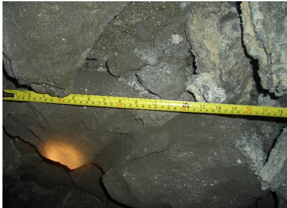
Foto N° 14.- Medición del espaciamiento de las discontinuidades para calcular los Índices Geomecánicos.
