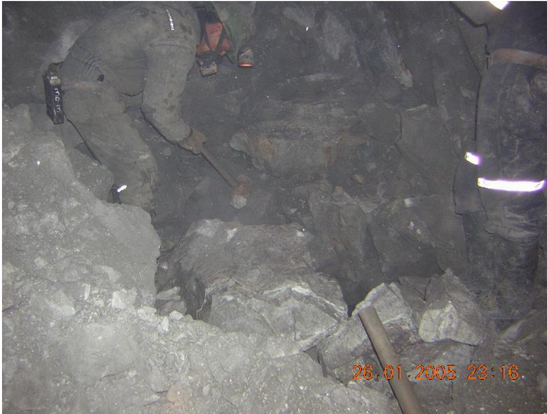
Foto N° 10.- Acumulación de Bancos de mineral en la parilla del echadero
