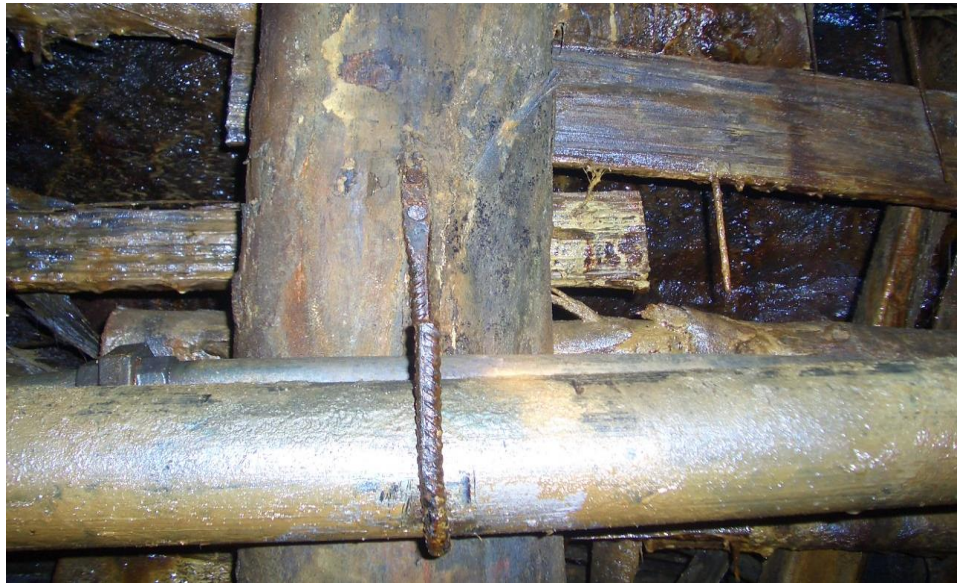
Foto N° 17- Correcta instalación de las tuberías de Agua y Aire Comprimido.
