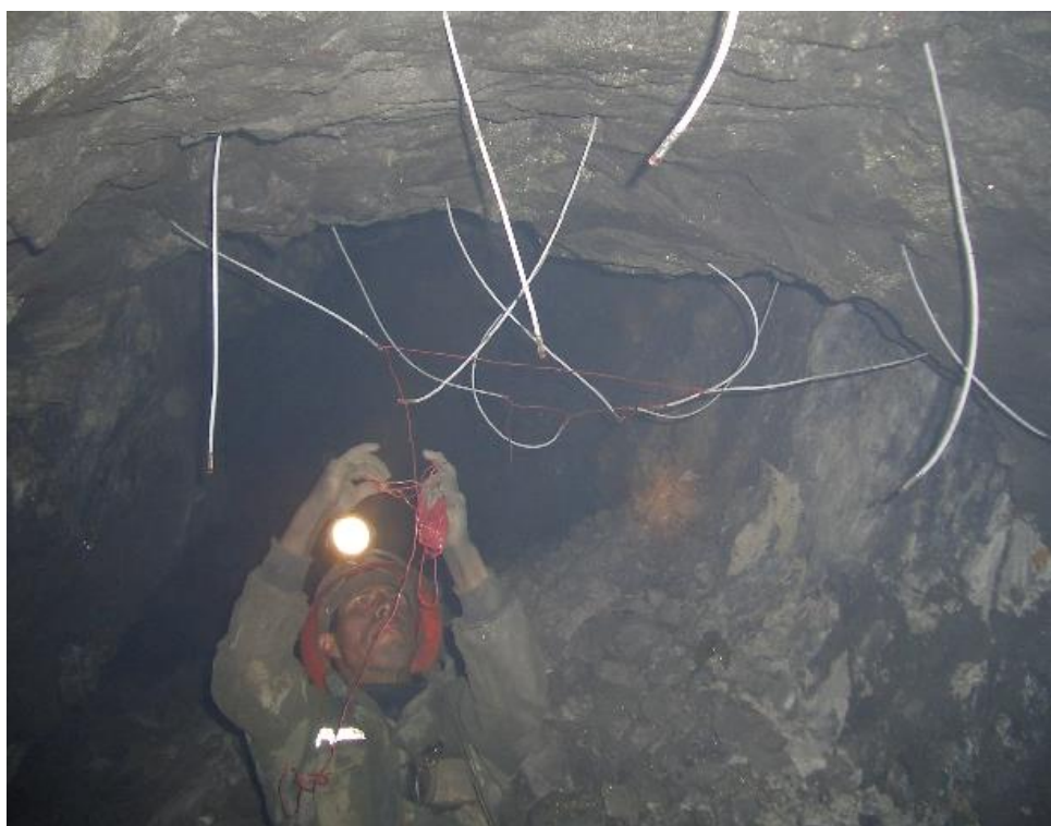
Foto N° 04.- Amarre de las guías ensambladas con cordón de ignición de los taladros verticales de un tajeo.
