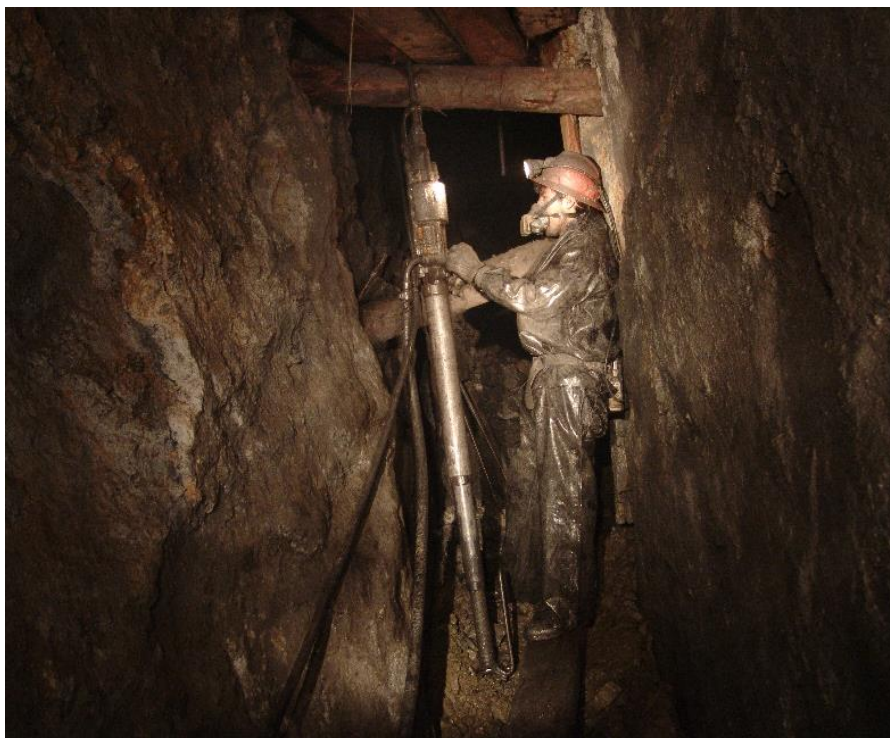
Foto N° 02.- Perforación vertical de un tajeo con Guarda cabeza
