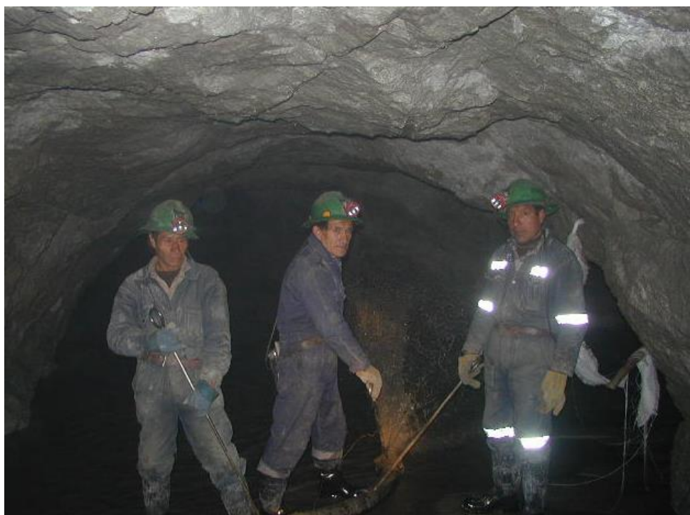
Foto N° 01.- Preparación del tajeo para su relleno hidráulico
