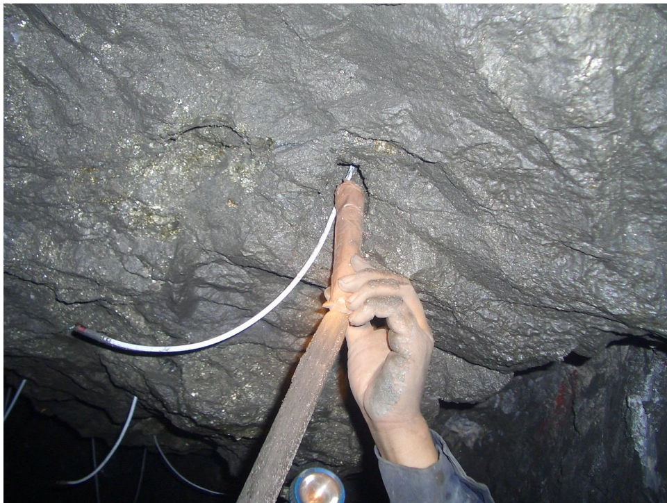
Foto N° 03.- Carguio de taladros con cartuchos de dinamita
