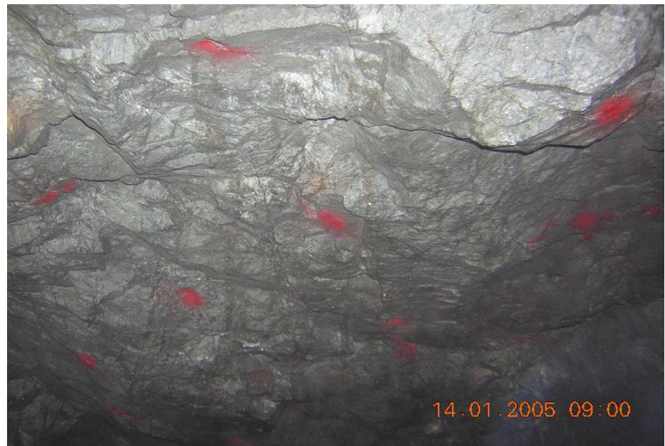
Foto N° 11.- Marcado con Pintura de de la Malla de Perforación
