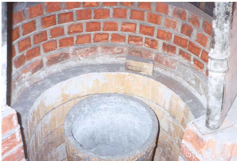
(Fig. 2) Horno de Pozo con Crisol de Carburo de Silicio en etapa de montaje
