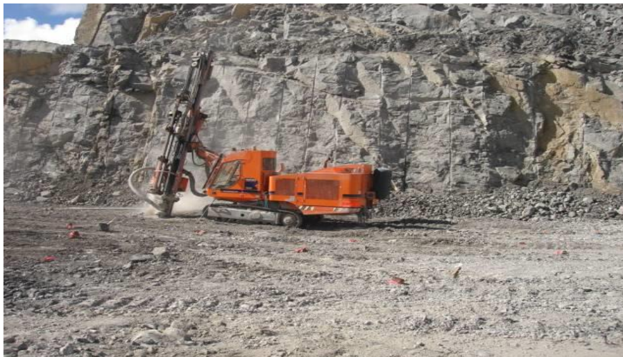
FIGURA 29: VISTA DE LAS MEDIAS CAÑAS GENERADAS POR PRECORTE.
