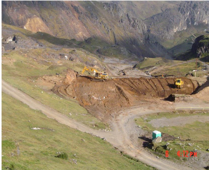
FIGURA 12: TRABAJOS INICIALES DE CONSTRUCCIÓN DE HAUL ROADS.
