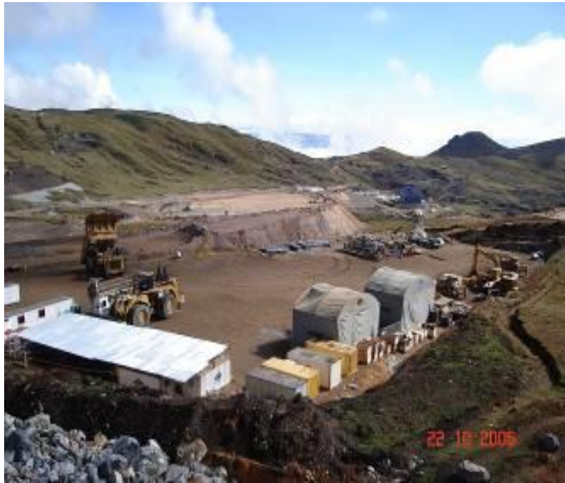
FIGURA 10: PLATAFORMA DE ARMADO DE EQUIPOS MINEROS
