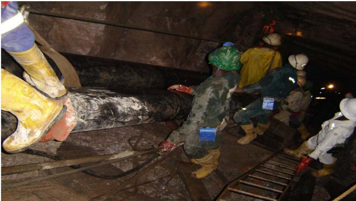
**Foto 5.6 Línea de retorno, tuberías de alvencus 300mm de diámetro 2004**
