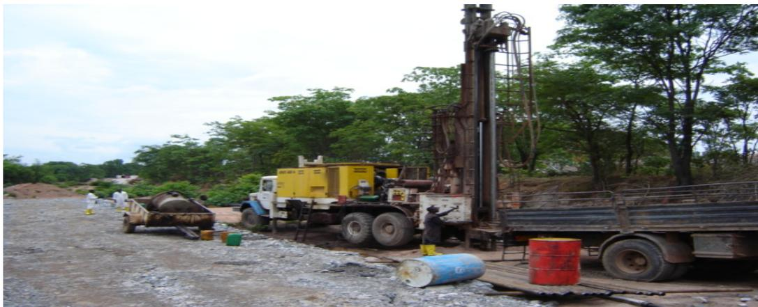
**Foto 5.2 Perforación de taladros desde superficie (En ejecución 2004).**
