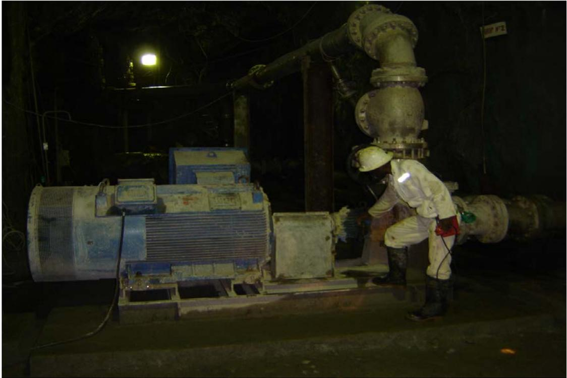
Foto 5.8 Estación de bombeo nivel 200, capacidad 600 m<sup>3</sup>/Hr. 2004
