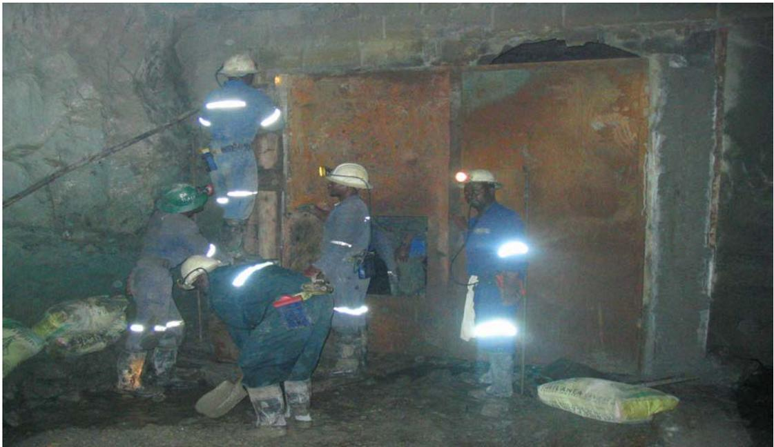
**Foto 5.1 Construcción de puertas de ventilación.**
