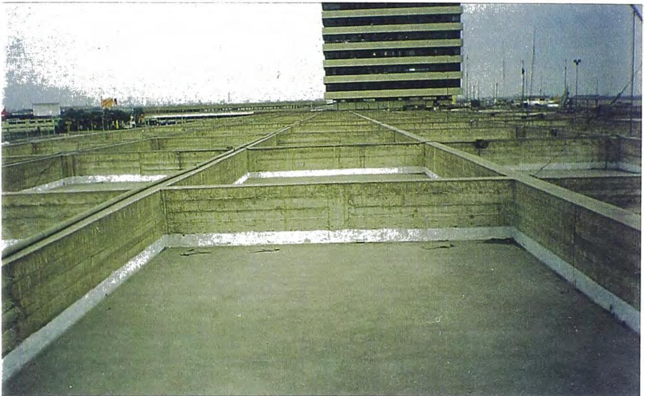
**Vista panorámica azotea del Aeropuerto, muestra ductos de 1" Ø, tendido paralelo vigas estructura del techo. que se encofró con cemento para dotarle mayor protección (5.2.2.1 Capítulo 5).**
