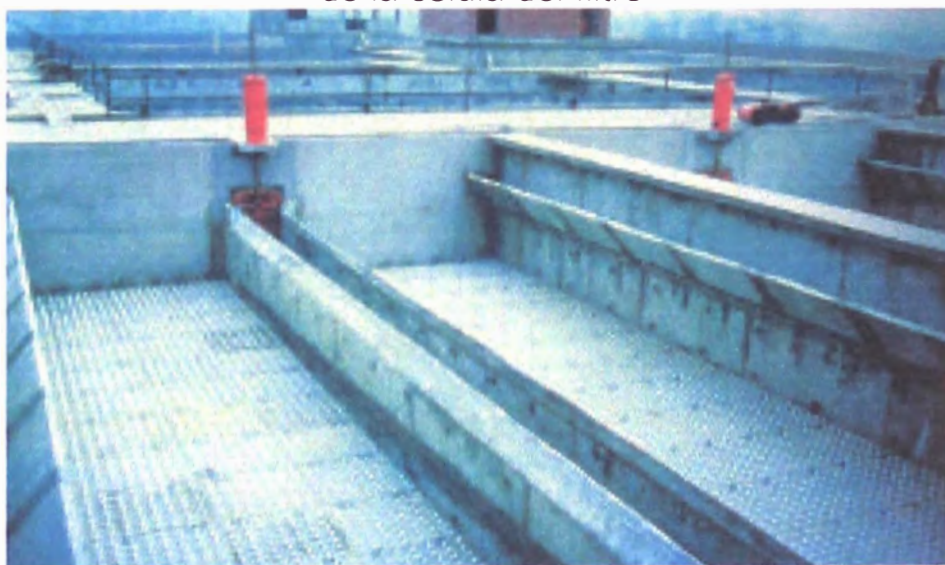
Figura 4.4. Placa de poliéster reforzado; su longitud es igual que la anchura de la célula del filtro
