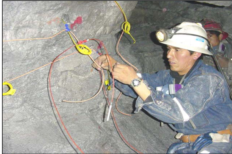
Foto N° 4. Personal realizando el amarre
