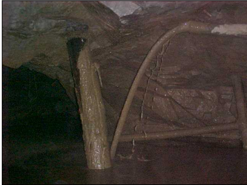
Foto N°7: Bloque 464 (zona explotada) en pleno relleno.
