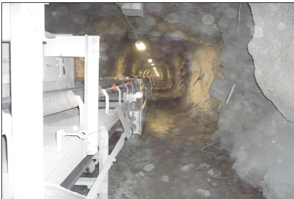
Faja transportadora No 3 salida de mina a superficie.
