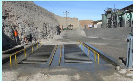
Construcción de lavadero de llantas planta de filtrado
