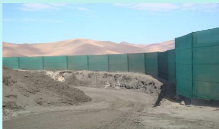
Construcción de cortina de control de polución en planta de filtrado
