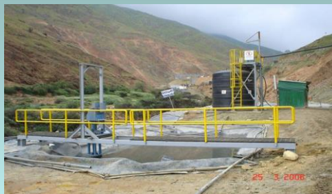
Construcción de lavadero de llantas planta de filtrado
