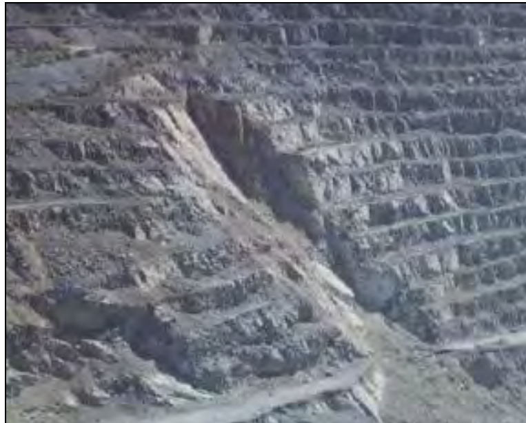
Figura 1.3.- Rotura en taludes de bancos en un tajo abierto (Zea, R.E., 2004)
