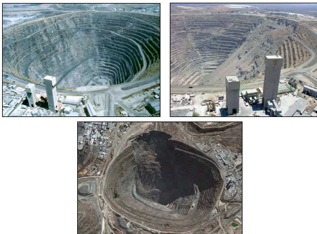
Figura 1.5.- Rotura rotacional en un talud global de un tajo abierto (Rabus, M., et al., 2009)
