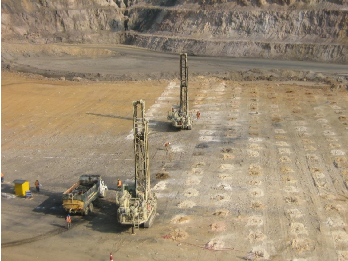
Figura 3.- Perforación con perforadoras DM45E
