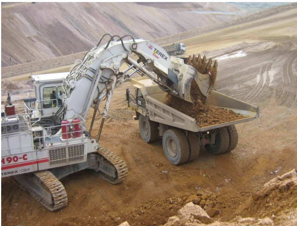
Figura 17.- Pala O&K cargando camiones 777F
