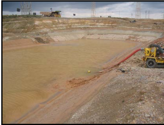
Fig. 6 Bombeo de agua de la poza
