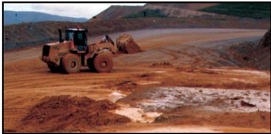
Fig. 7 Cargador 966 acumulando lodos
