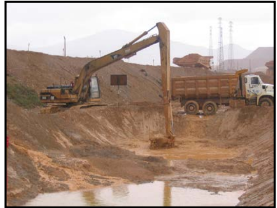
Fig. 7 Limpieza de poza con excavadora
