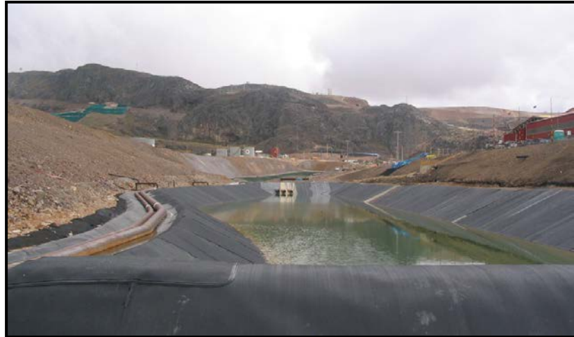
Fig. 10 Poza de recolección de agua acida.
