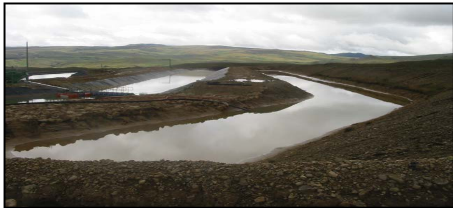
Fig. 3 Pozas sedimentadoras
