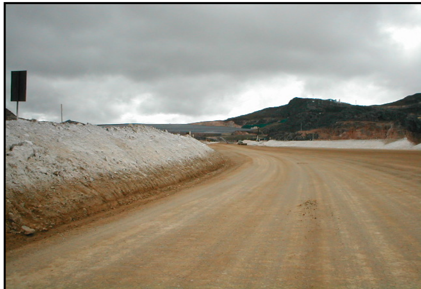
Fig. 6. Vía con un sistema de drenaje operativo
