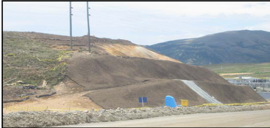
Fig. 4 Revegetación de talud
