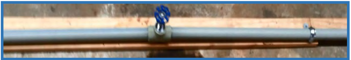
Foto n°81: Válvula de 32 mm PP-R.
