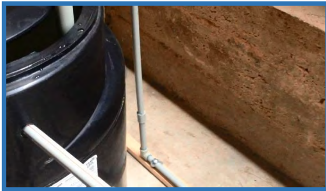
Foto n°47: Línea Prueba de 16 mm.
