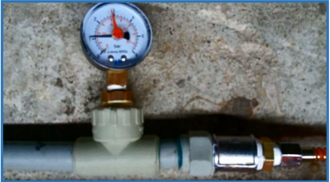
Foto n°87: Presión de aire en la tubería de polipropileno.
