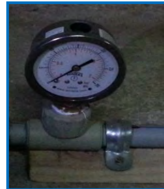
Foto n° 30: Manómetro Instalado.
