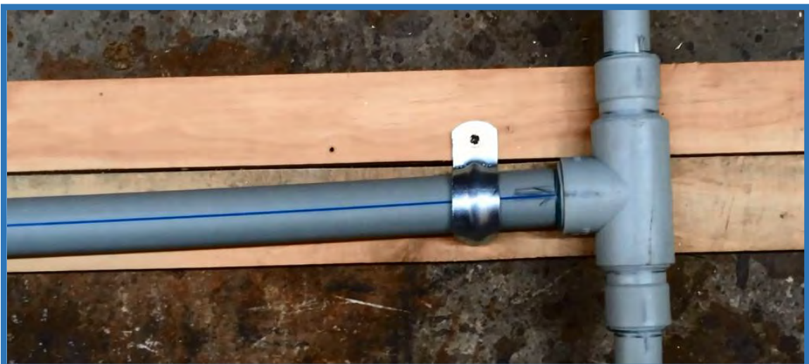
Foto n°77: Tubería de 25 mm, Tee de 25 mm, Dos Red 25 x 20, Tubería de 20 mm.
