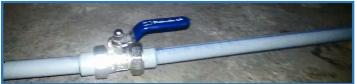
Foto n°82: Válvula de bola de 20 mm PP-R.
