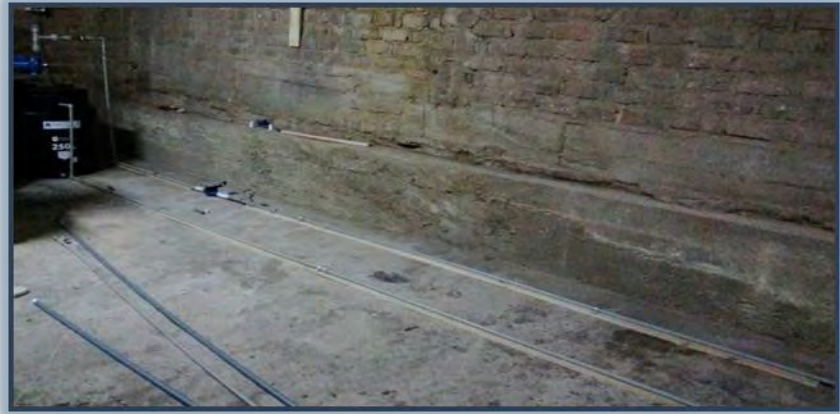
Foto n° 26: Línea de Prueba de las Tuberías
