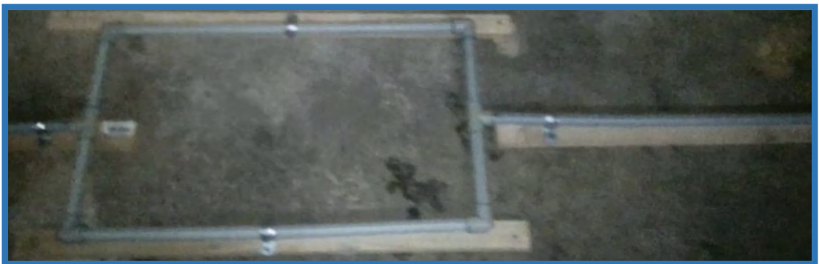
Foto n°72: Dos Tee de 20 mm PP-R.
