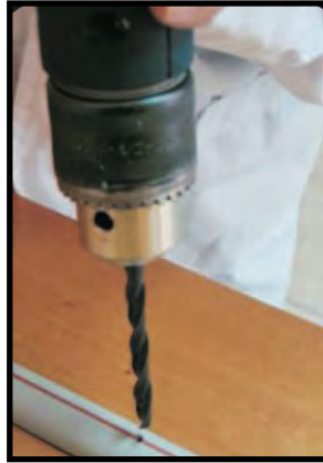
Foto n° 6: Rectificar la perforación.
