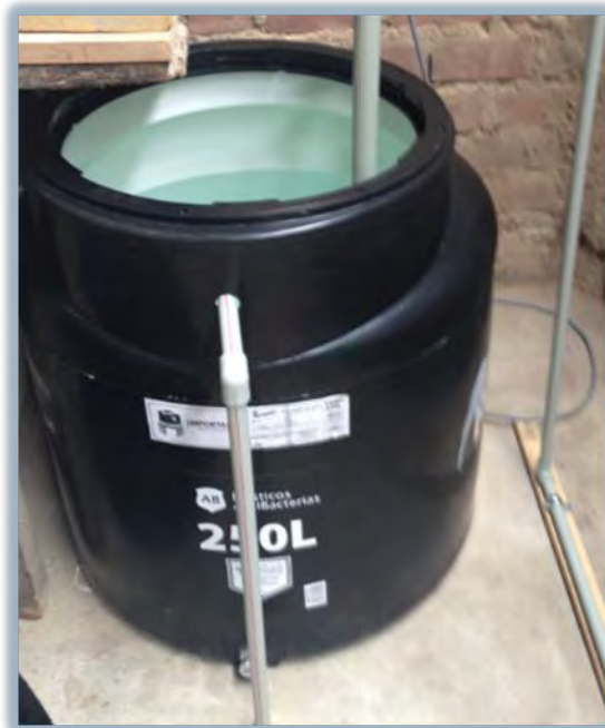
Foto n° 18: Tanque de agua 250 L.
