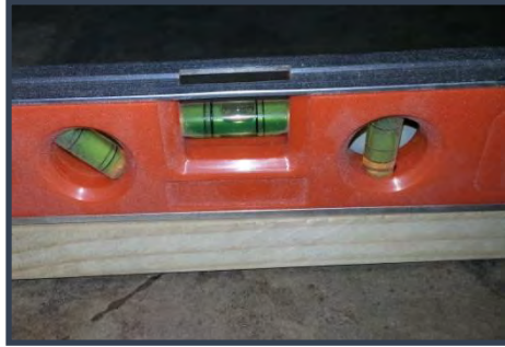
Foto n°34: Nivel donde se asienta la tubería.
