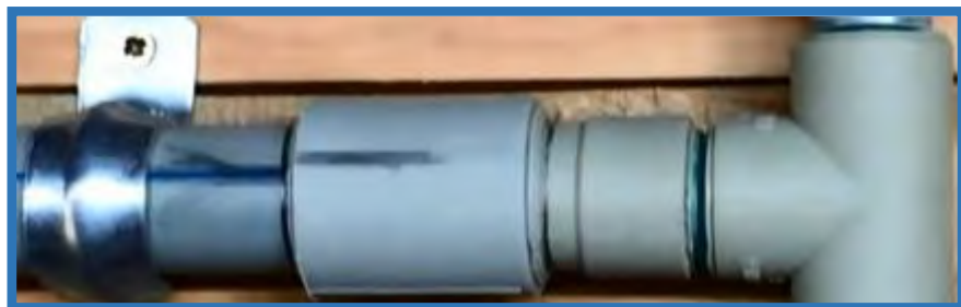
Foto n°75: Tubería de 25 mm, Red 25 x 20 y Tee de 20 mm.
