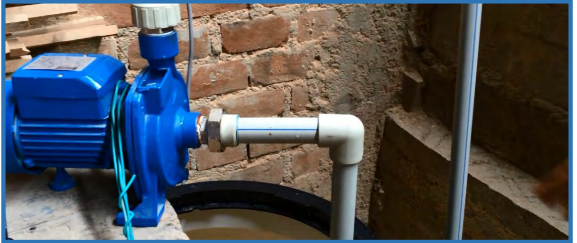
Foto n°60: Se cambió toda la línea de impulsión por 32 mm.
