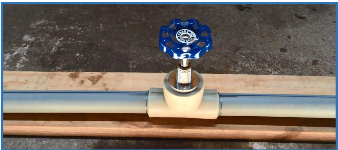
Foto n°80: Válvula de 25 mm PP-R.
