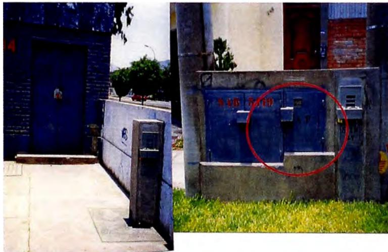
Fig. 22 Subestación con equipo de medición de alumbrado público
