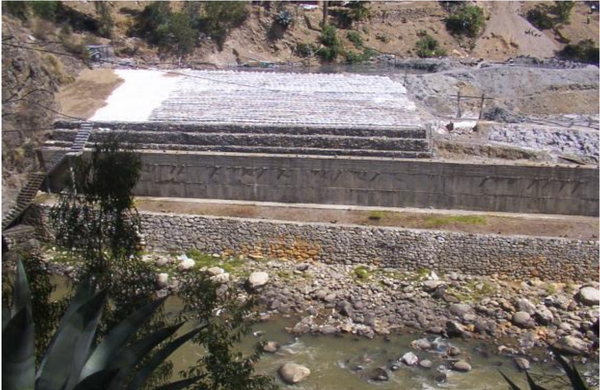
Cancha de Relave, inicio del Encapsulamiento
