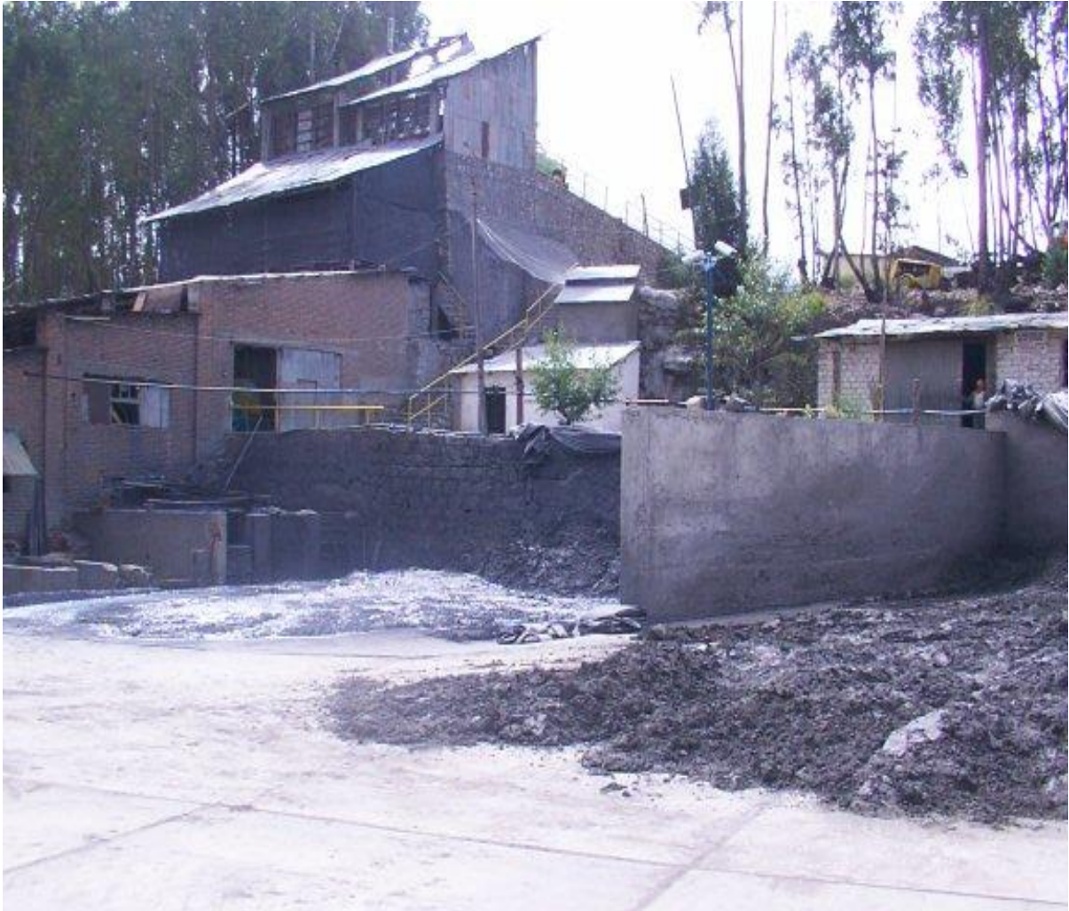
Vista De la loza De Los concentrados Plomo y zinc
