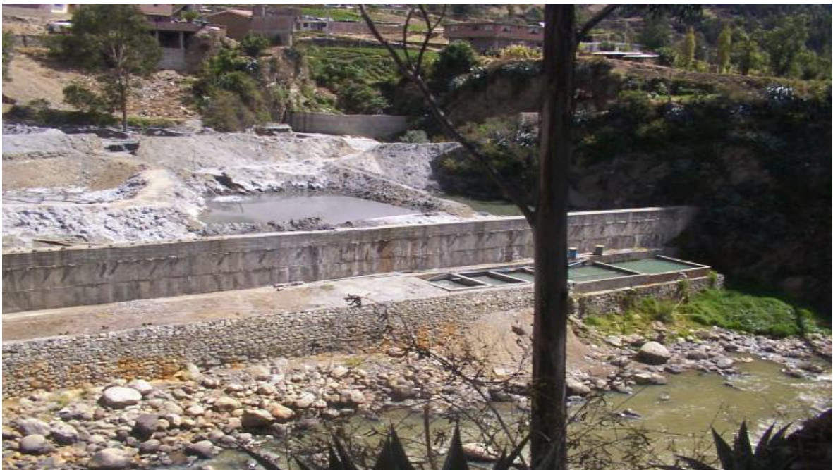
Se aprecian las pozas de Sedimentación y del tratamiento de las aguas clarificadas
