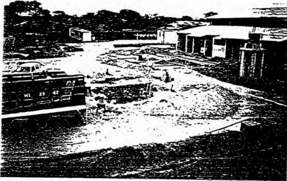
Vista de la ubicación de la Subestación Chulucanas Excavación de la base del Transformador de Potencia
