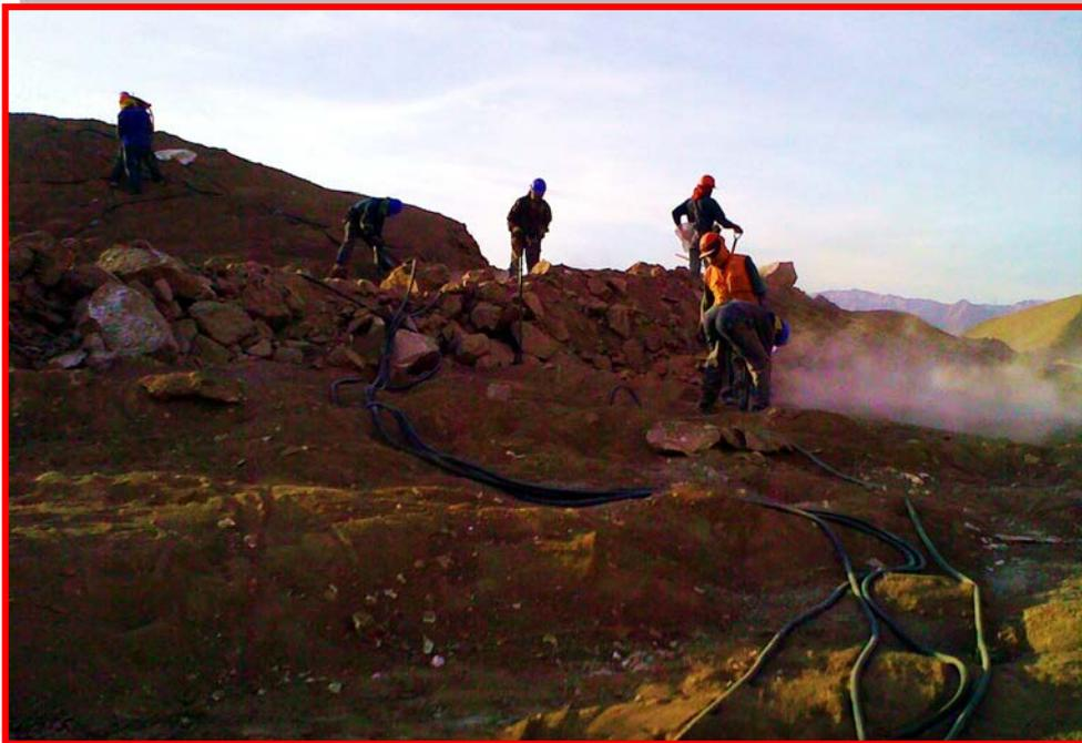
Foto N° 25: Trabajos de perforación y voladura para el proyecto de reubicación de aguas servidas de Moquegua, actualmente en ejecución.
