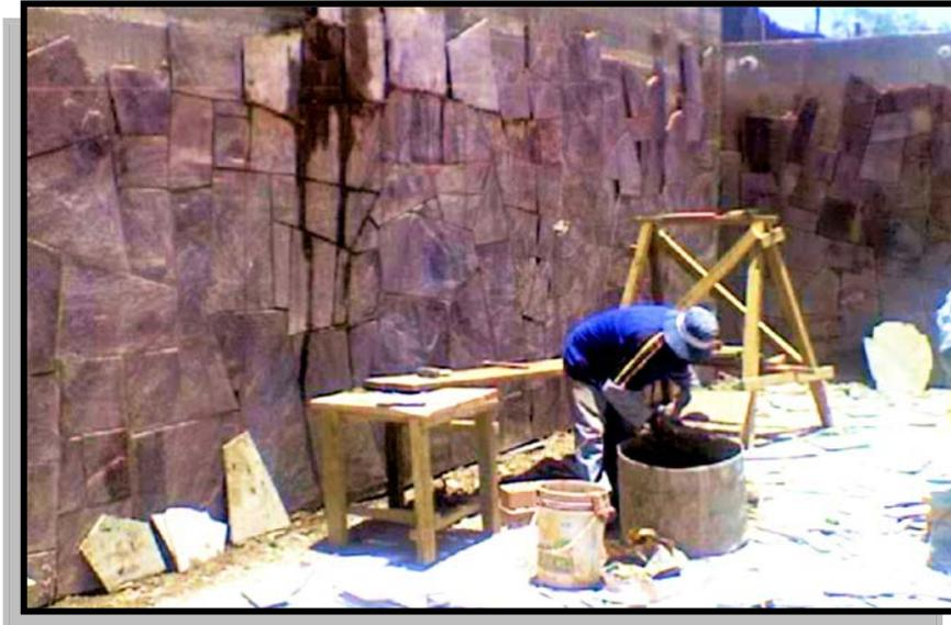
Foto N° 7: Colocando el revestimiento a los muros del parqueo en el futuro coliseo cerrado de Moquegua.
