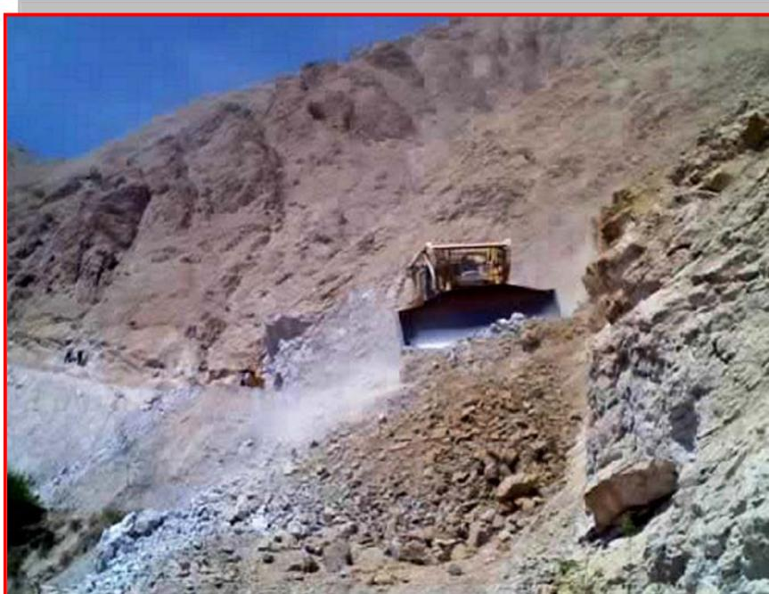
**Figura Nº 3.8: Construcción del acceso a la cantera KGIBEDA II para dar inicio a las operaciones comerciales el 2004**
