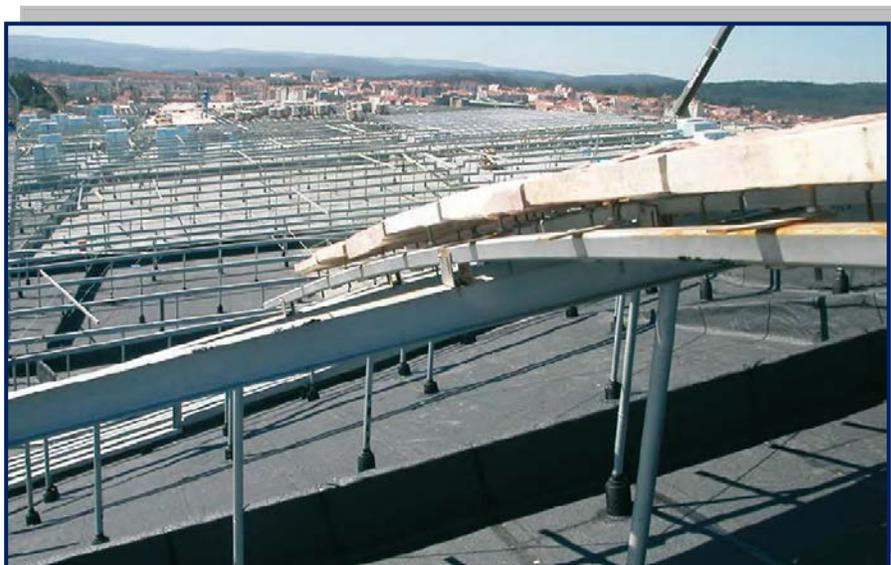
**Figura Nº1.2: Detalle de la colocación de la piedra laja en el techo de los edificios sobre la estructura de acero.**
