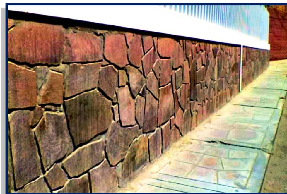
Foto N° 18: Revestimiento con piedra laja irregular en el muro exterior del mercado municipal de Torata.
