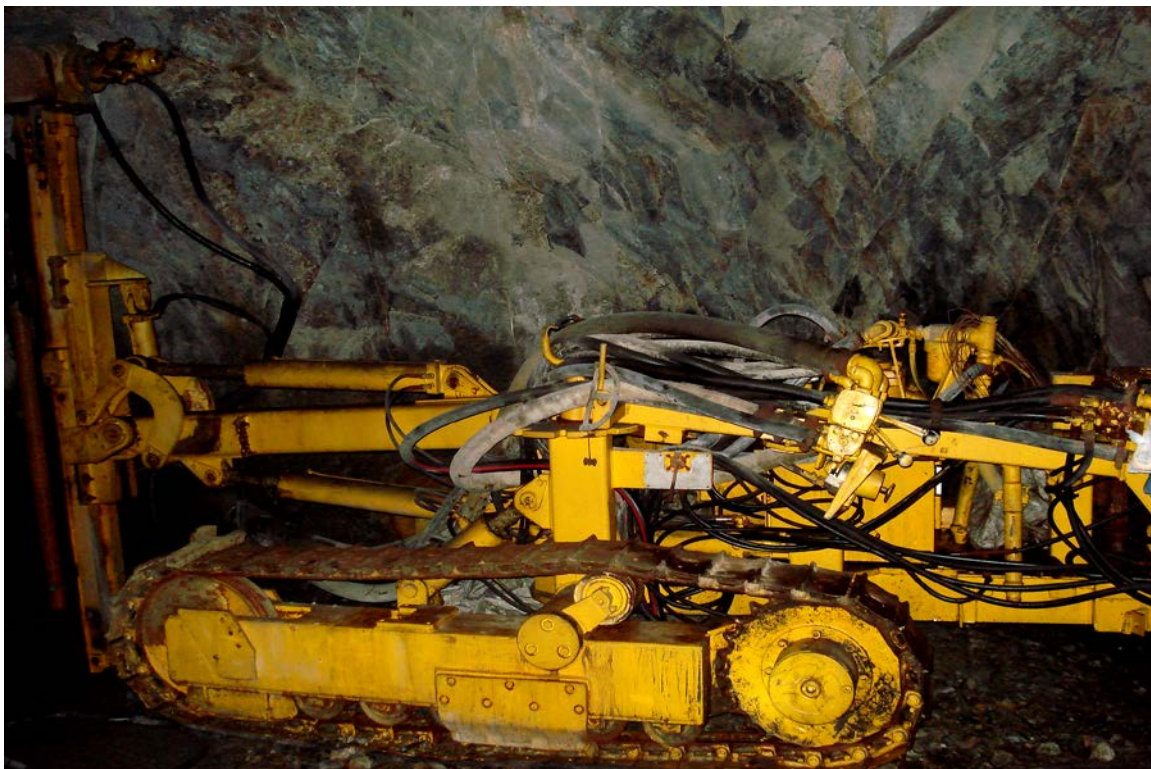
Fig.15: Vista del DTH en operación.
