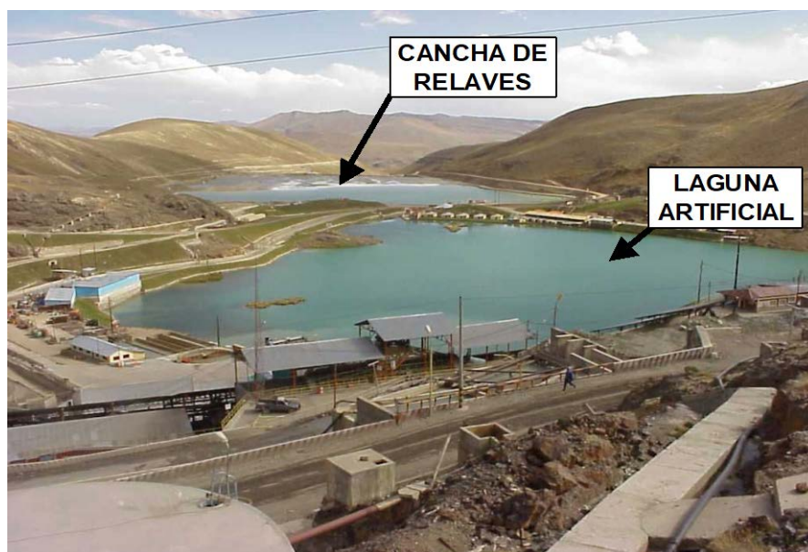
Figura 21: Vista general de la cancha de relave de la Planta Concentradora de San Rafael.
