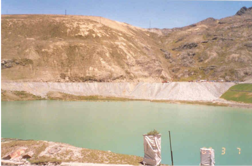
Foto N° 8: Vista panorámica de la desmontera 35, que se halla al NW de la alguna Chogñacosta y cerca de las instalaciones de la mina, actualmente recibe los desmontes de las labores mineras del nivel 4550m.
