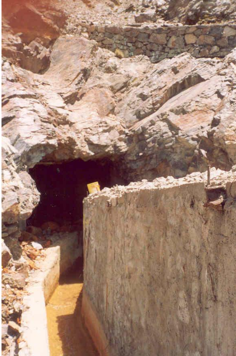
Foto N° 7: Bocamina 42 a , se ubica en una ladera de 35° en la entrada se halla la chimenea 72, el agua sale a través de un canal de concreto. La galería está excavada en roca filitas.
