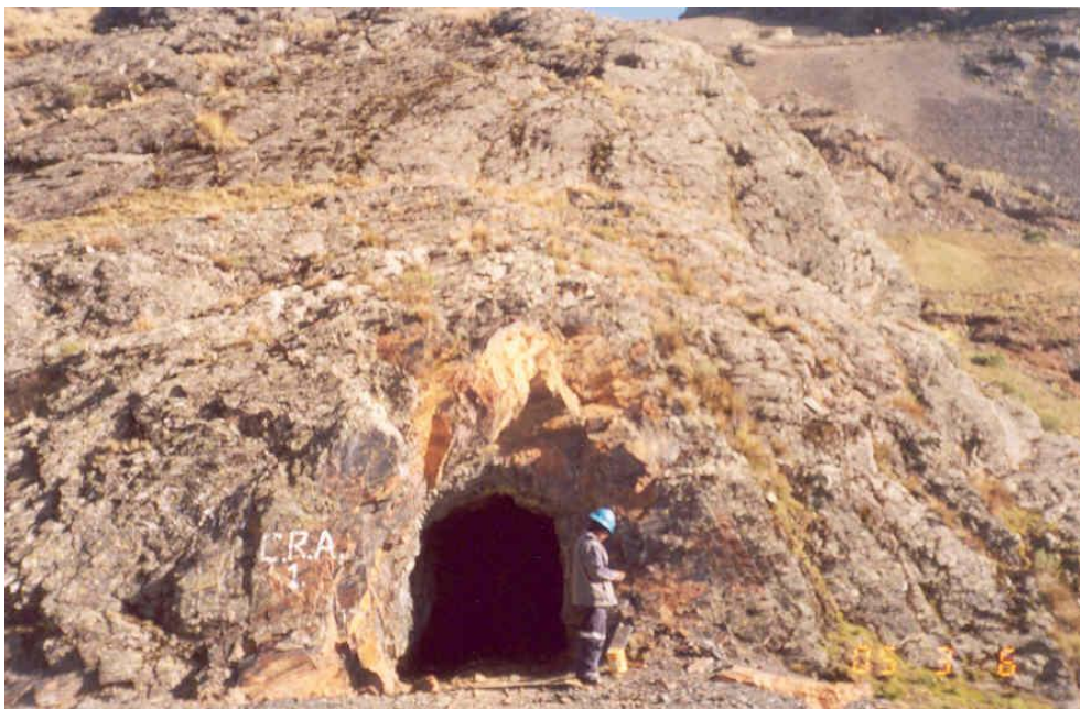
Foto N° 6: Bocamina 29 , ubicado en el sector y margen derecha de la quebrada El Rosario, debajo de una ladera rocosa de 62 a 65° de pendiente, excavada en roca filita, el agua sale de la excavación en forma eventual.
