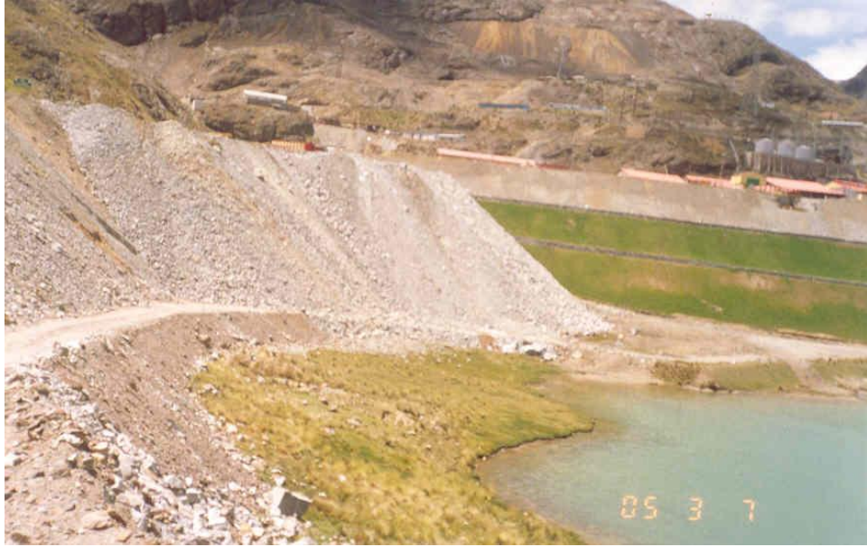
Foto N° 10: Los materiales acumulados en la desmontera 35, se hallan cerca de la laguna su pendiente es mayor a 35^{\circ} .
