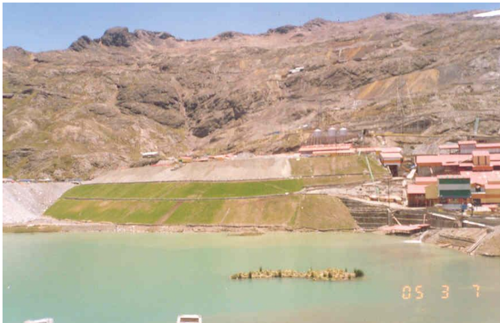
Foto N° 11: Desmontera 36 , ubicada cerca de las oficinas de MINSUR y la laguna Chogñocota, parte de este desmonte tiene un talud mayor a 33^{\circ} y está revegetado.
