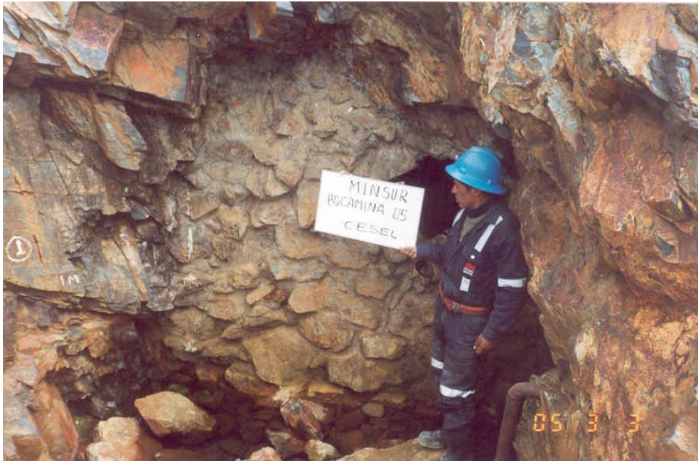
Foto N° 4: Bocamina 5 , ubicado en una ladera rocosa del área de Umbral, se halla cerrada con mampostería de piedra que puede ser mejorado y complementado. Los trabajos de cierre deben prever mejorar el drenaje de las aguas que salen de la excavación.
