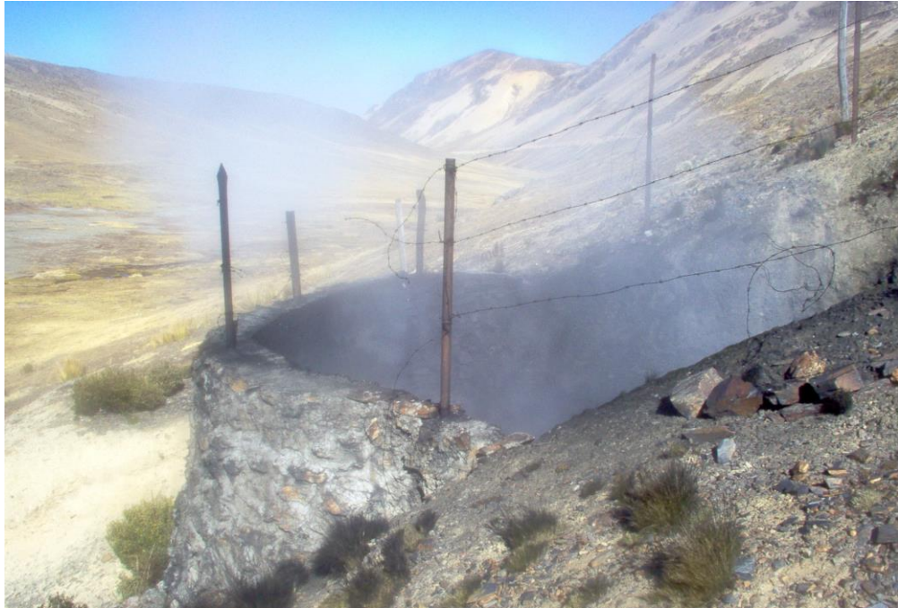
Foto N° 3: Chimenea 11 denominada Alimac se ubicada a 4 750 msnm, en la zona Umbral altura aproximada=600 m, No tiene acceso vehicular.
