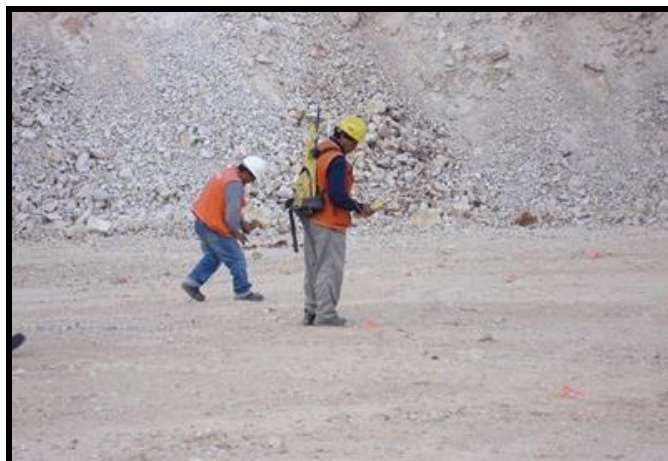
Foto 21 Topógrafos levantando la malla de perforación
