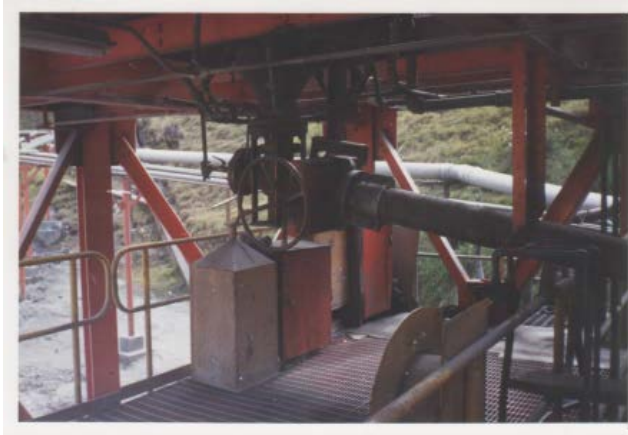
En ambas fotos se muestran las válvulas de compuerta de cada uno de los Silos
