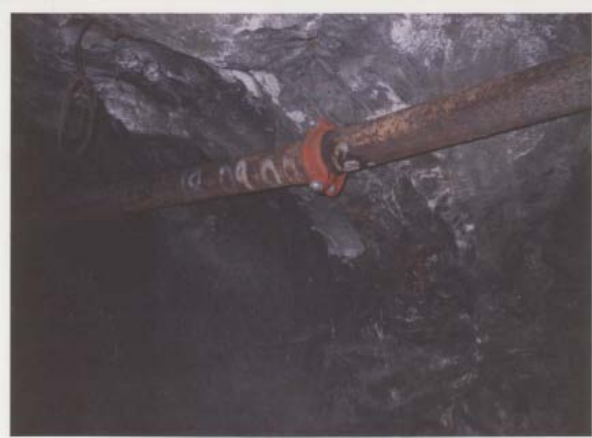
Se muestran las Bridas Vitaulicas de fierro de 5" Ø uniendo tubos de fierro del mismo diametro.
