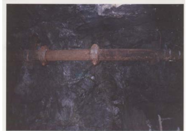
Se muestran las Bridas Vitaulicas de fierro de 5" Ø uniendo tubos de fierro del mismo diametro.
