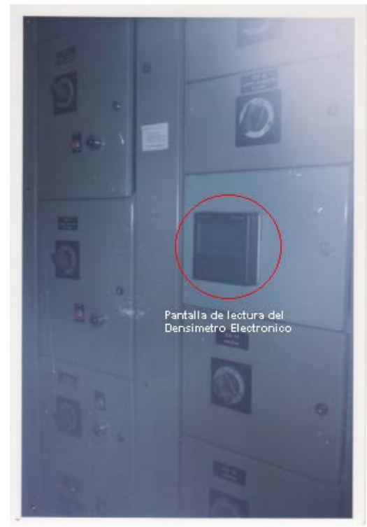
En ambas fotos se observa al densímetro electrónico de la planta de Relleno, en la izquierda el sensor y en la derecha la pantalla de visualización de las densidades del Relleno Hidráulico
