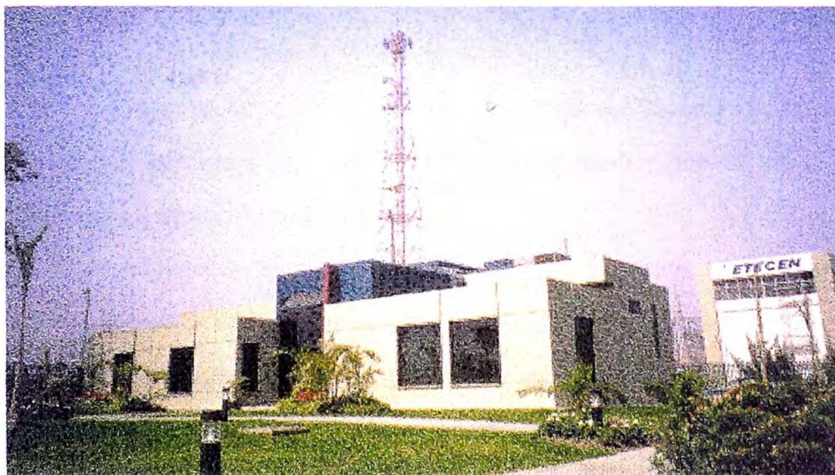
Fig. 3.2 Edificio del Centro de Control de ETECEN
