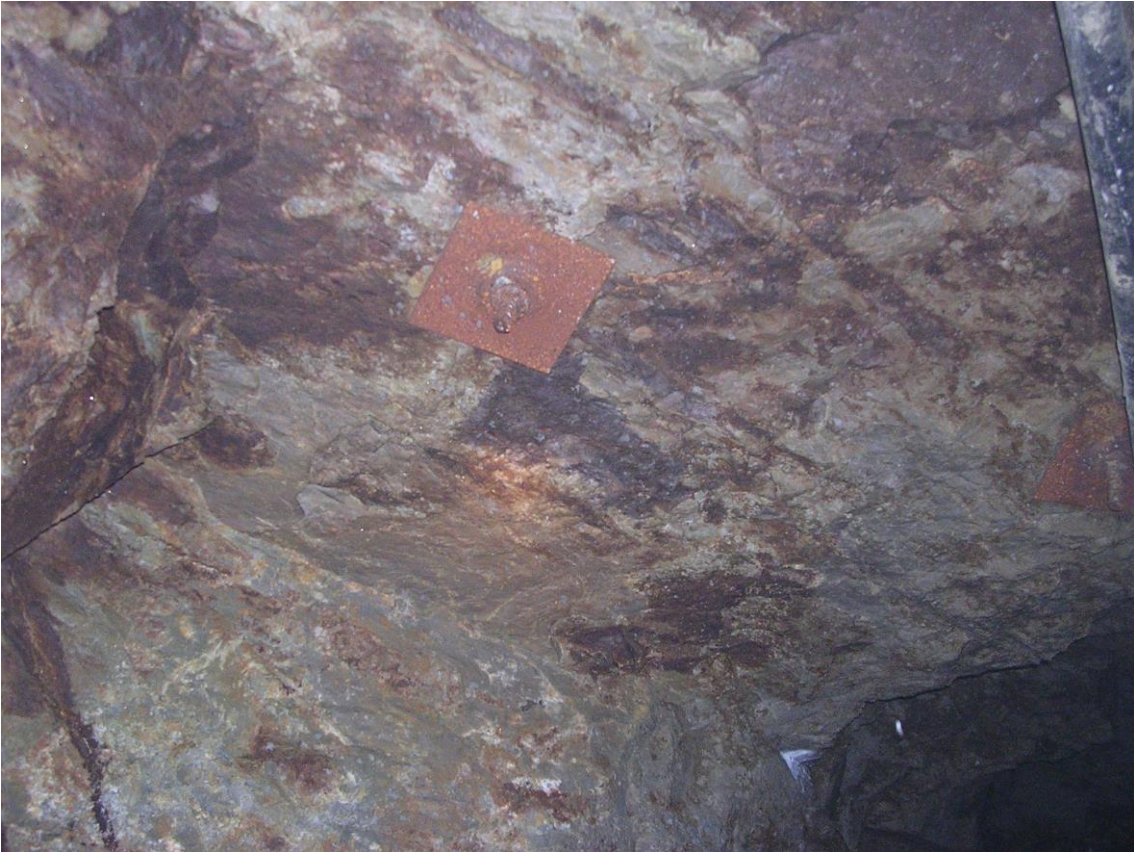
Perno cementado con cem-bolt colocado en una cara de un plano de fracturamiento.
