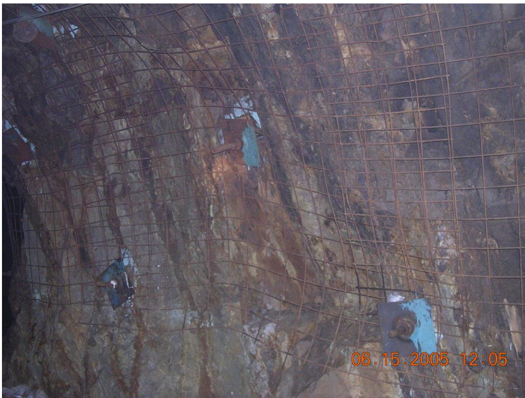
Pernos cementados sistemáticos, se aprecia el traslape correcto.
