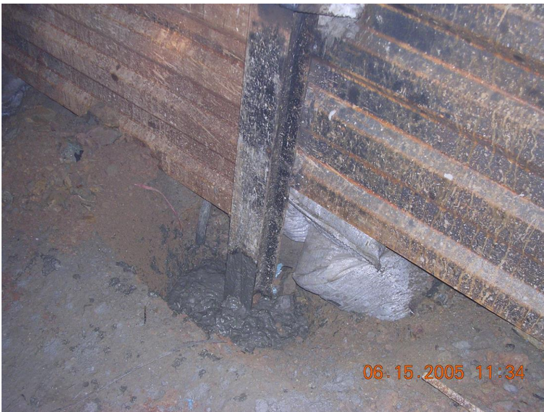
Bases con dados de cemento para mejor anclaje de las cimbras.
