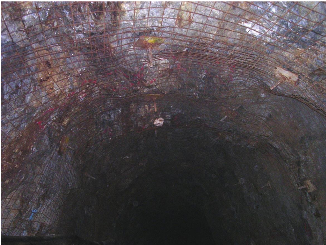
Cinta metálica o strap trabajando en zona de veta IF/MP, RP-990
