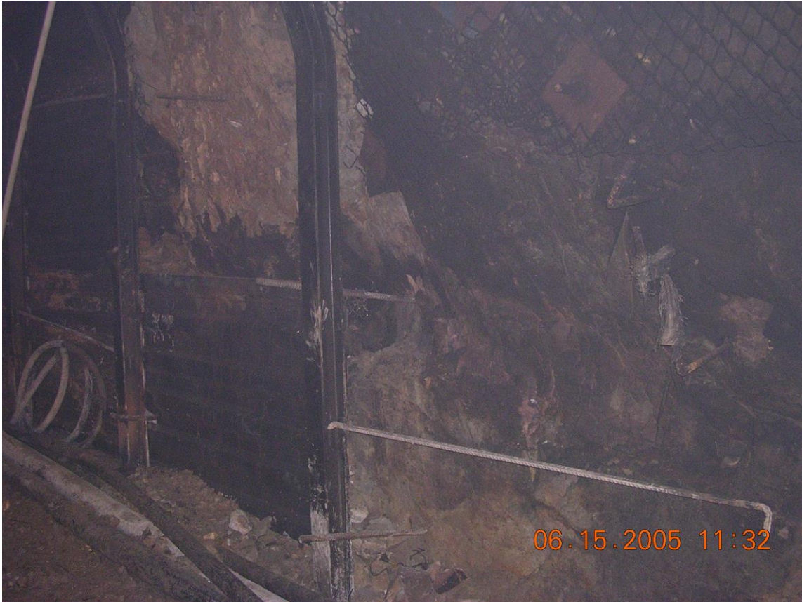
Cimbras donde se aprecian los anclajes a los haspiales
