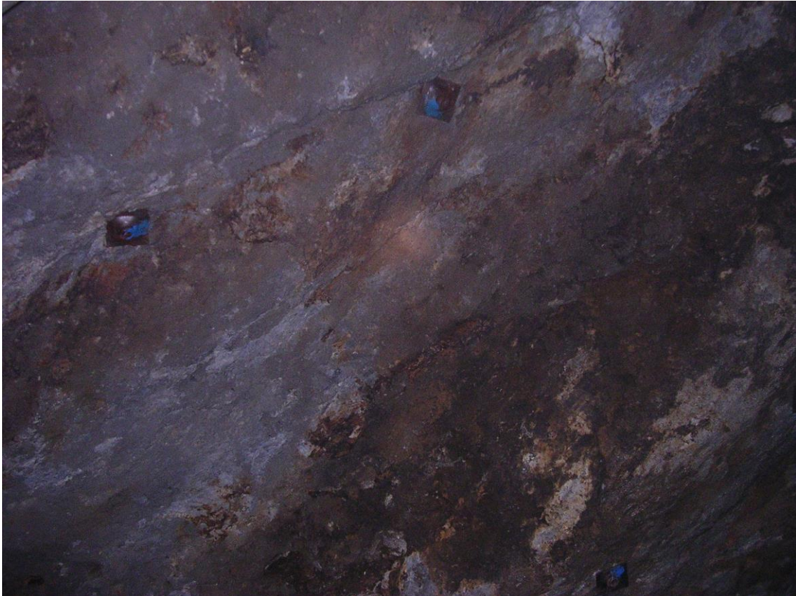
Split set de 6 pies colocados en el R-380, Zona Norte
