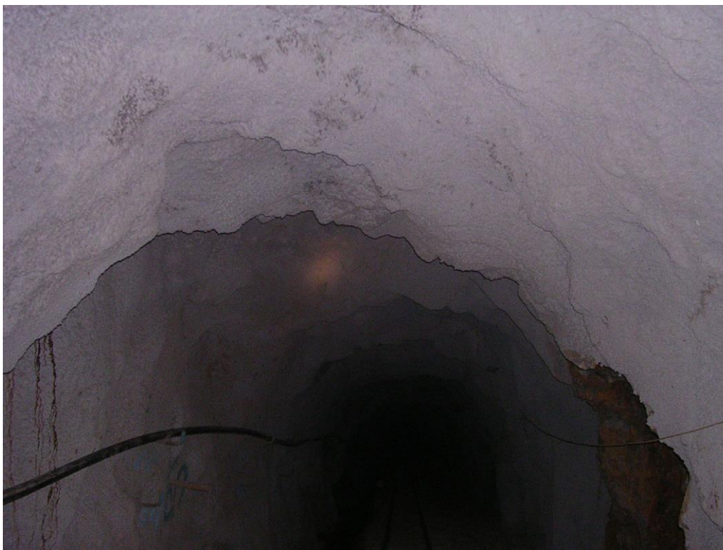
Shotcrete colocado en labor del Nv. 500
