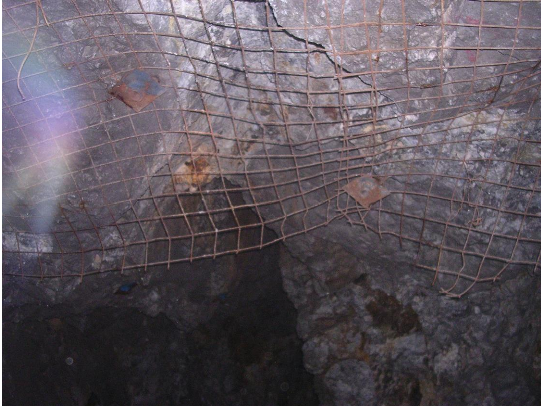
Malla electro soldada en tajo, sujeta con split set – R-380 Zona Norte
