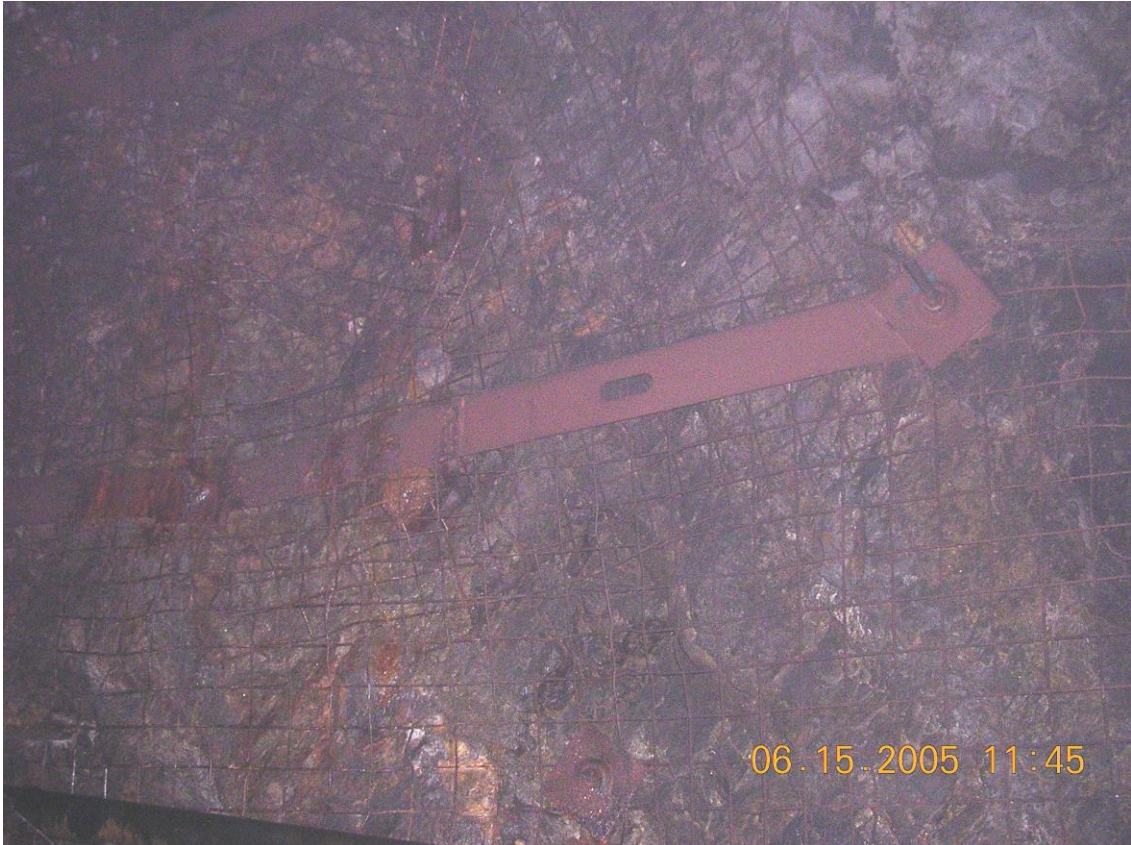
Cinta metálica o strap trabajando en zona de veta IF/MP, RP-990
