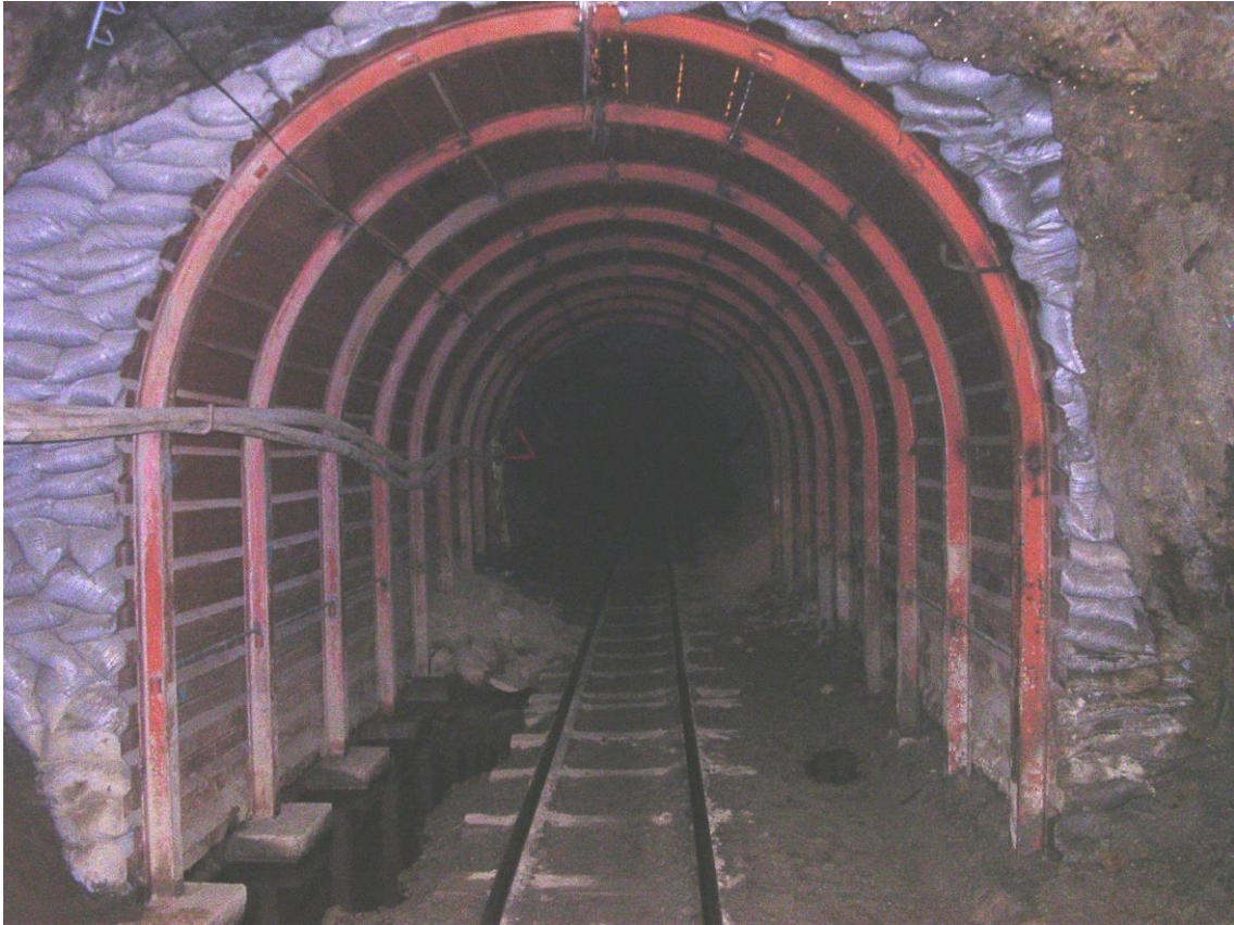
Cimbras de 3x3 m. Nv. 500 - Norte
