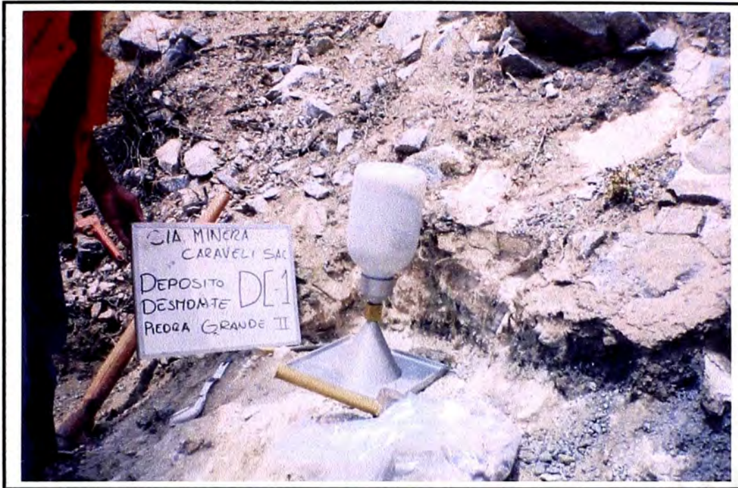
Fotografía N° 08: Vista de la Densidad de campo DC-1.
