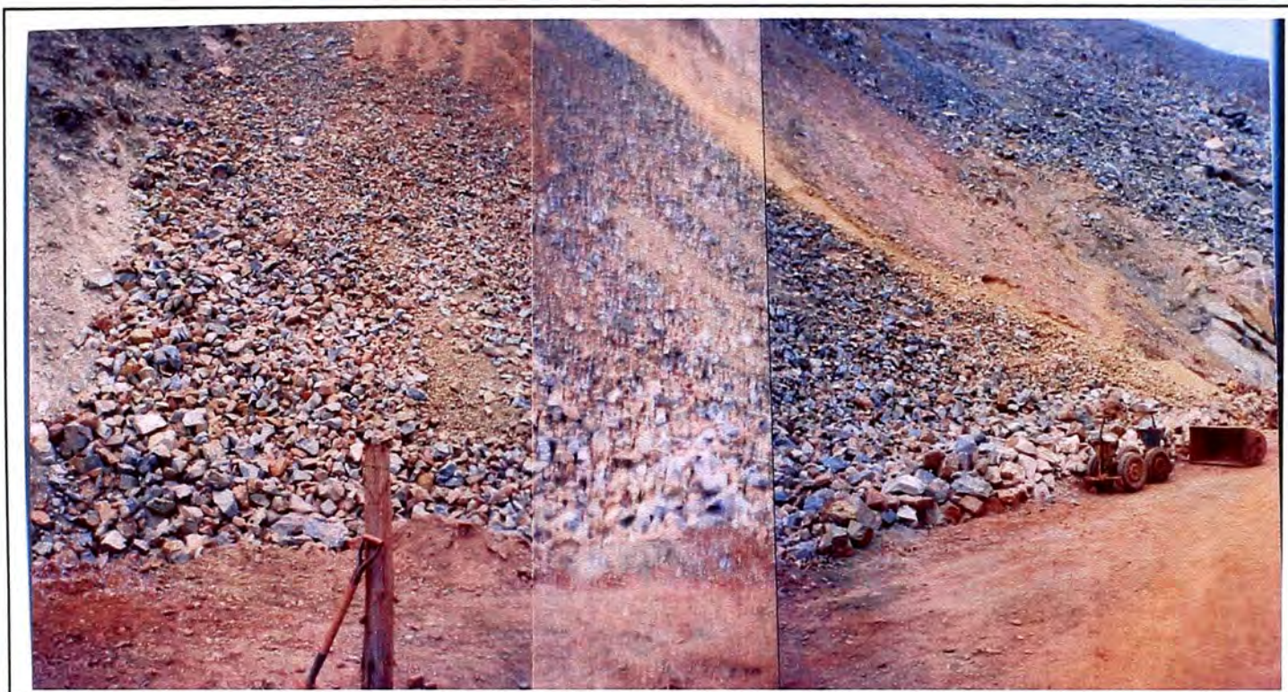
Fotografía N° 01 : Vista general del Depósito de Desmonte "Piedra Grande II", nivel 2860
