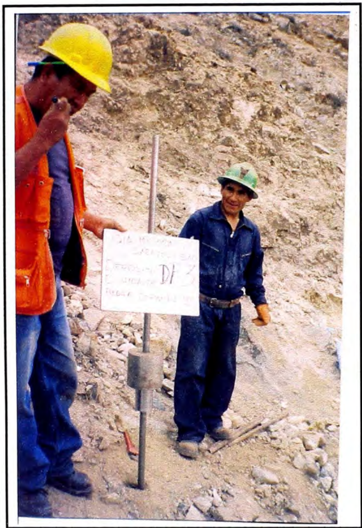
Fotografía N° 04: Vista de la ejecución del ensayo de exploración DP-3
