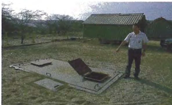
Figura 33. Poza API Bateria 401
