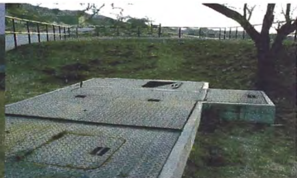
Figura 34. Poza API Bateria 175
