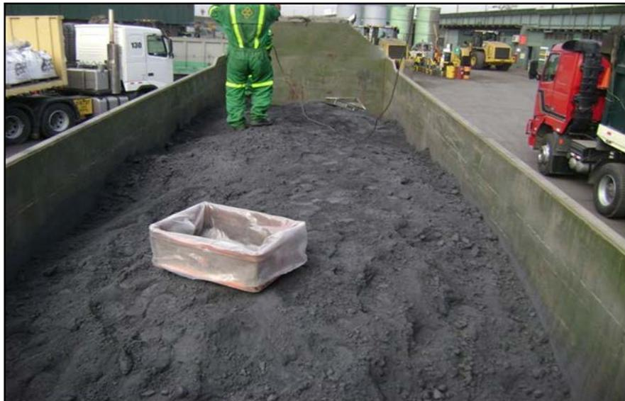
Personal de Cormin, inicia el muestreo con sonda helicoidal, para determinación de calidad.
