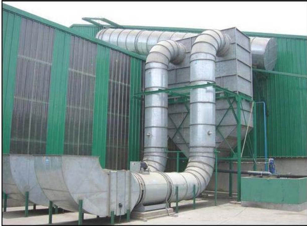
**Ilustración Vista Panorámica de las toberas del Sistema de Ventilación-Encapsulado.**
