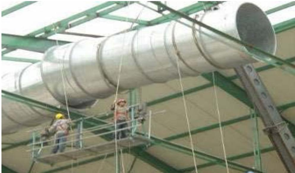
**Ilustración Operarios instalando toberas del Sistema de Ventilación a Presión Negativa**
