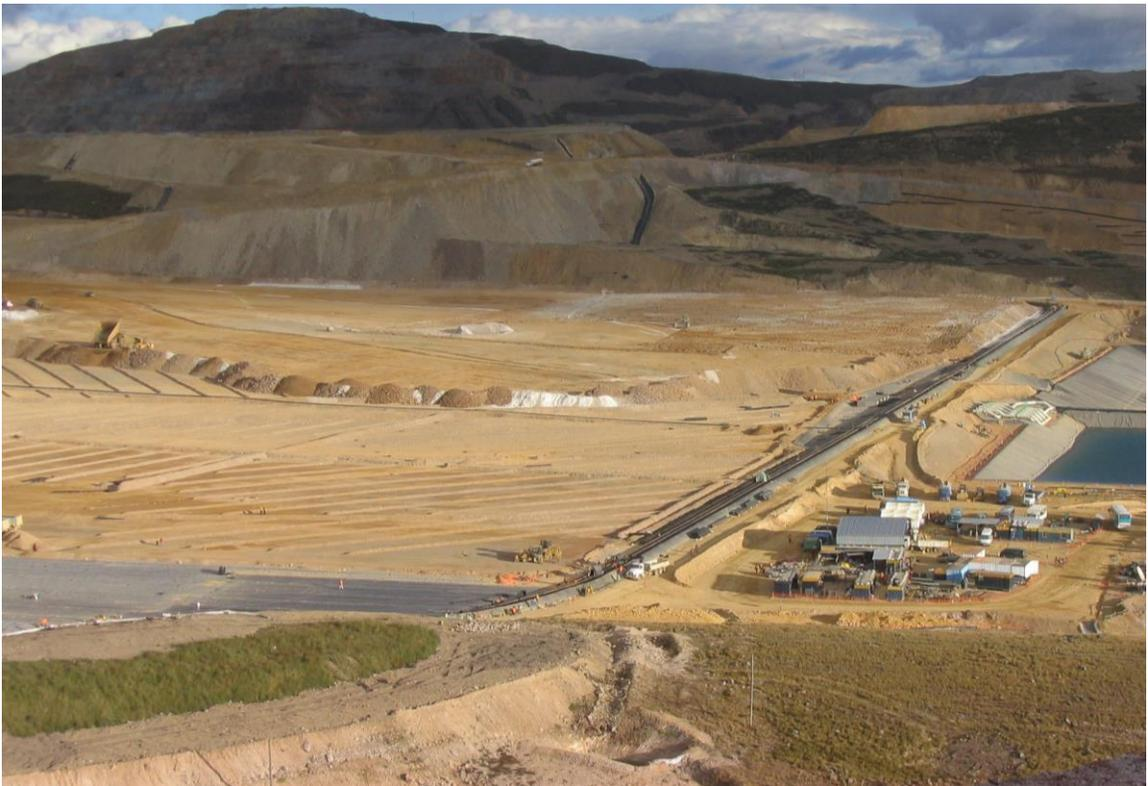
**FOTOGRAFÍA 12.** Lixiviación en el leach pad, mediante el tendido de mangueras y goteo o aspersión de la solución cianurada.
