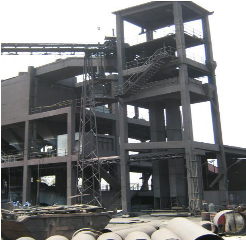
Llegada de faja donde se montará la zaranda y todo el sistema antipolvos.
