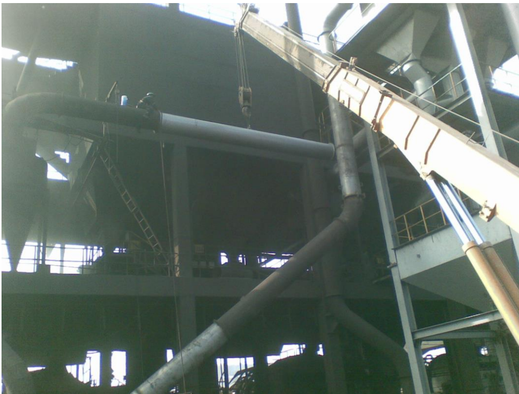
Montaje de la tubería de succión con la grúa de 25 TN y 35 mt de izaje.
