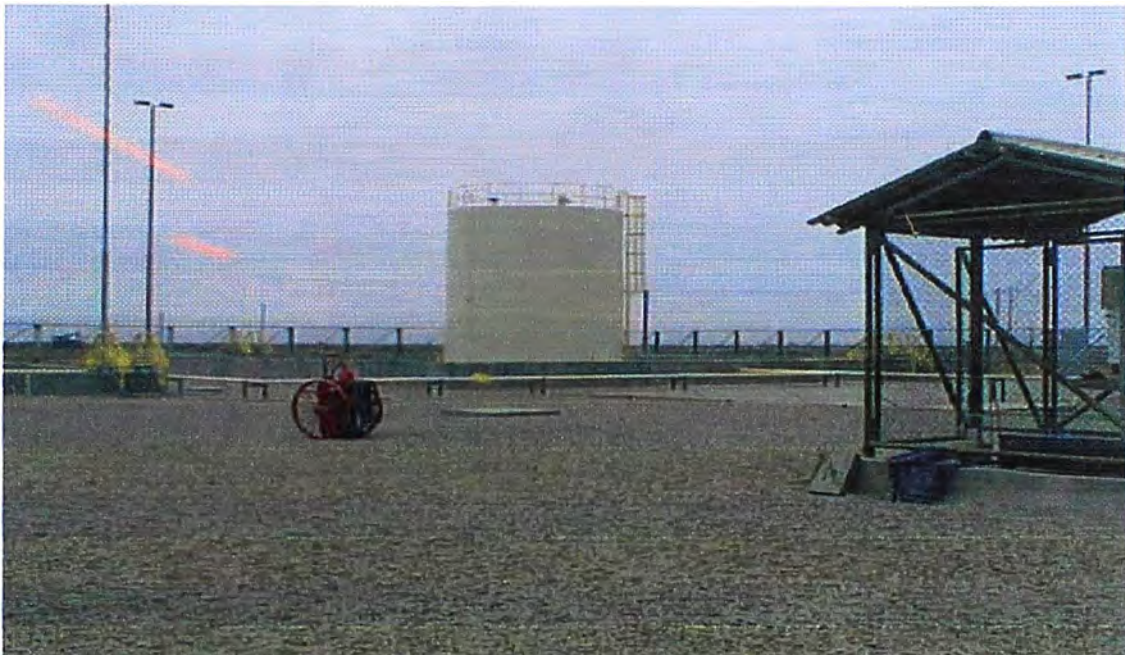
Foto N°15 Vista de Tanque Principal en Batería 608
