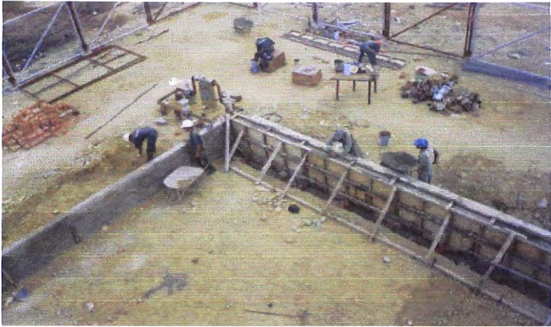
Foto N°5 Construcción de muros de contención.
