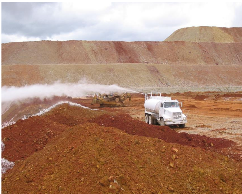
Fig. 4.7: Cisterna realizando la adición de lechada de cal en el pad
