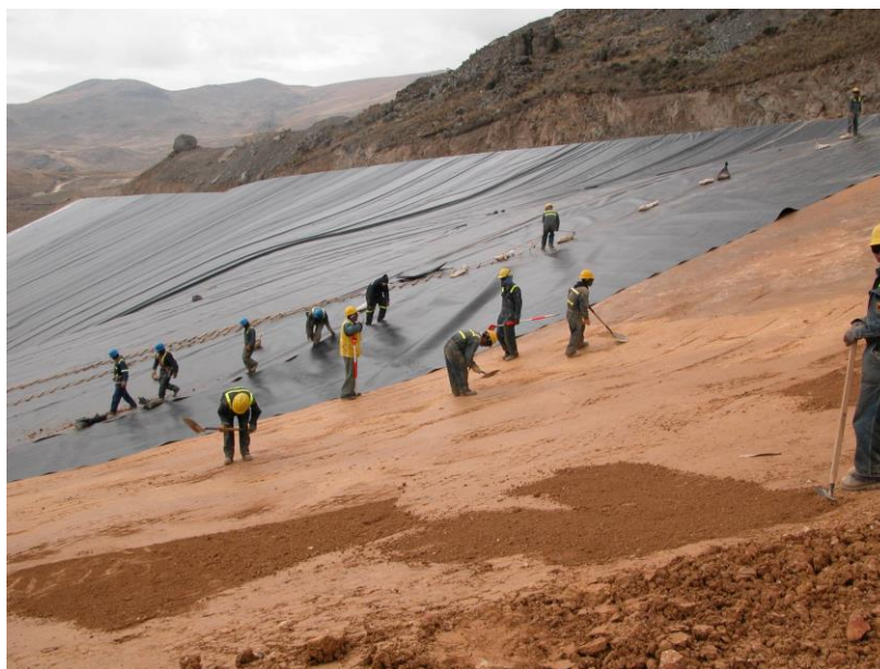
Fig. 4.2: Tendido de geomembrana en la base del pad
