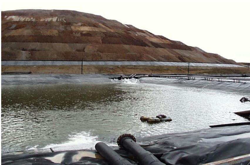
Fig. 1.10: Pozas para el almacenamiento de soluciones cargadas de oro y plata
