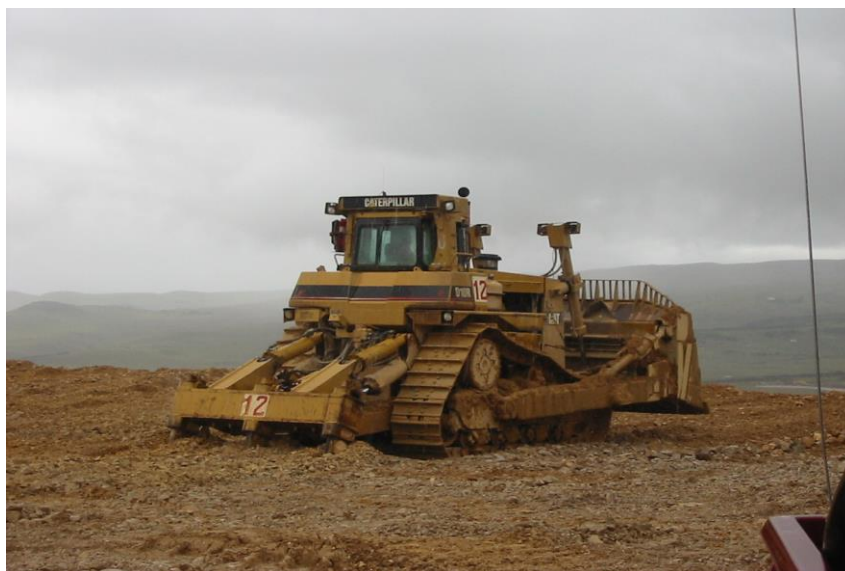
Fig. 4.6: Equipo realizando el ripeo de una celda
