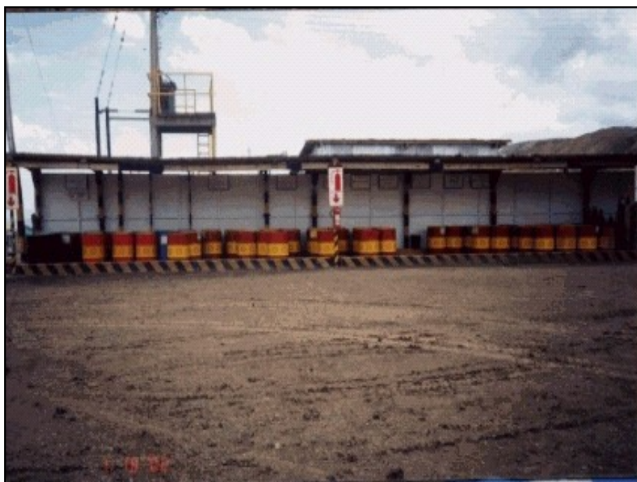
Foto B16 Cilindros de aceites y lubricantes dentro de sus bermas antiderrames
