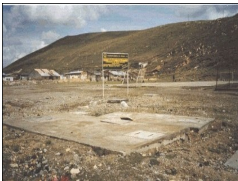
Foto B8 Tratamiento de Desagües, mediante Tanques Sépticos. Planta Concentradora Huaracaca
