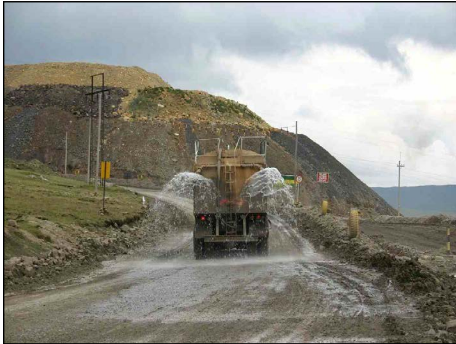
Foto B21 Camión cisterna regando las vías de acceso
