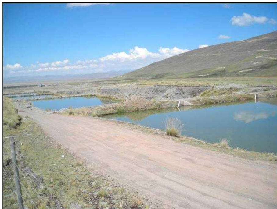
Foto B5 Tratamiento de Aguas Servidas, mediante Lagunas de Oxidación. Colquijirca
