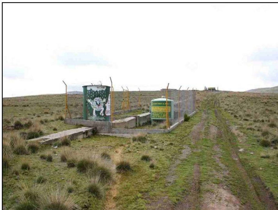
Foto B3 Sistema de Tratamiento de Agua Potable: Sedimentación – Filtración – Desinfección. Colquijirca
