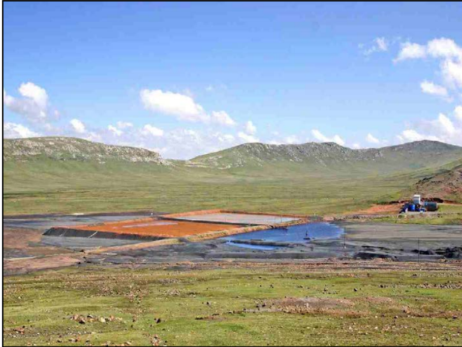
Foto B19 Vista panorámica de la planta de tratamiento de aguas de mina (ácidas)
