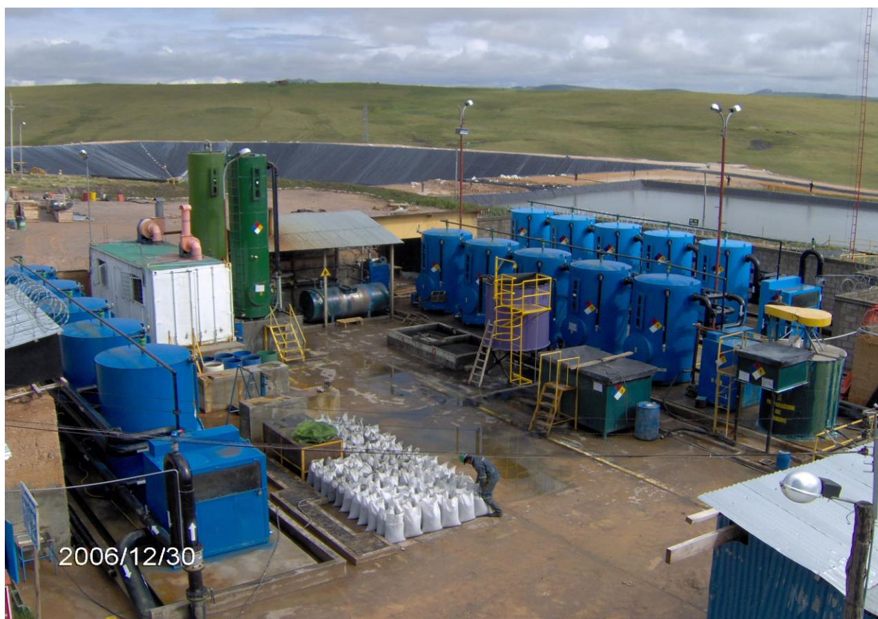
Foto Nro.7 Planta de Adsorcion
