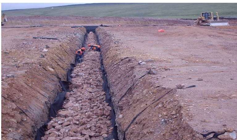
Foto Nro. 17 Instalación de los Subdrenes
