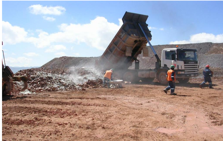
Foto Nro. 4 Descarga del Mineral en el Pad
