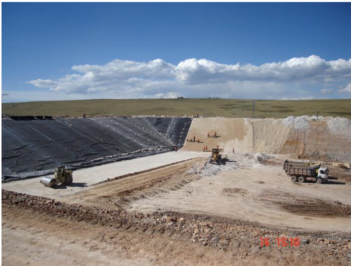
Foto Nro. 31 Instalación de la Geomembrana
