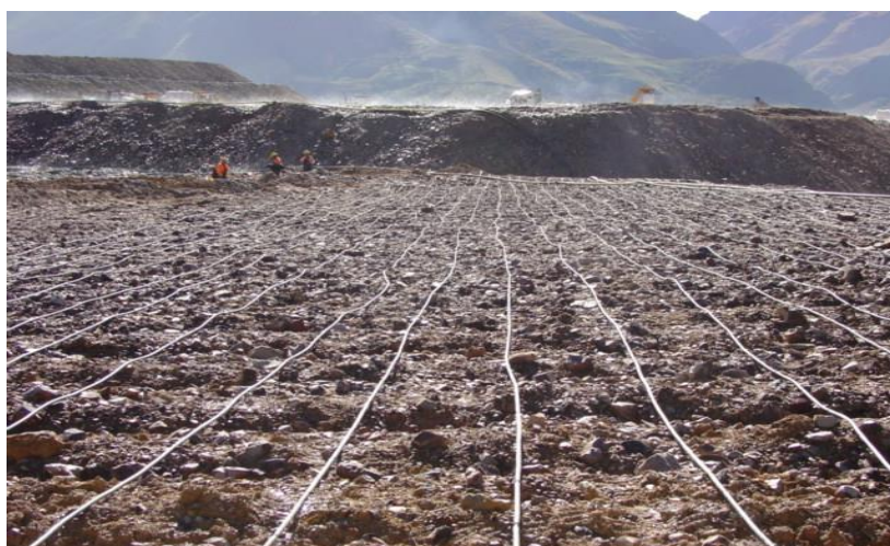
Foto Nro. 25 Riego por Goteo
