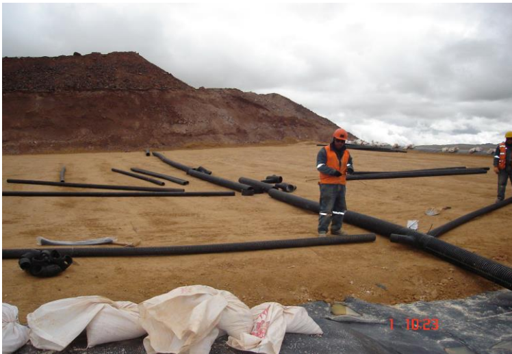
Foto Nro. 19 Instalación de los Drenes
