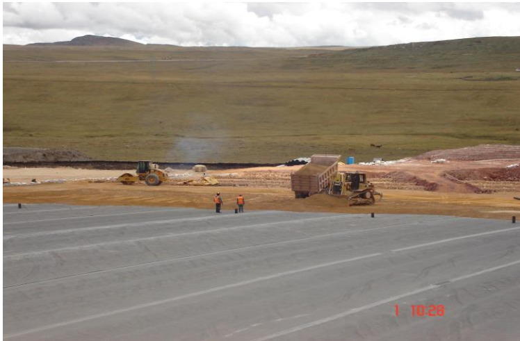
Foto Nro. 18 Pad con Geomembrana y Colocación de Soil Liner
