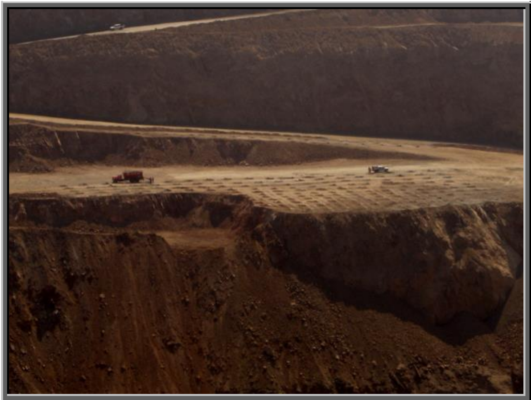
Área de voladura en el Nv. 641 durante el carguio de taladros con AN/FO
