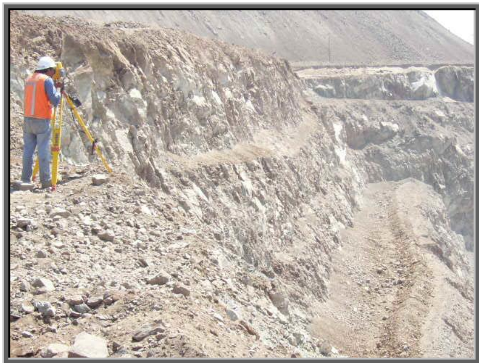
Foto 04.- Levantamiento de taludes con laser.
