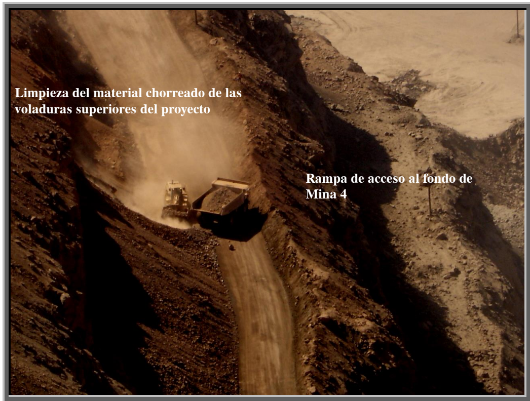
Recuperación de material chorreado en rampas inferiores de la Lado Norte Mina 4
