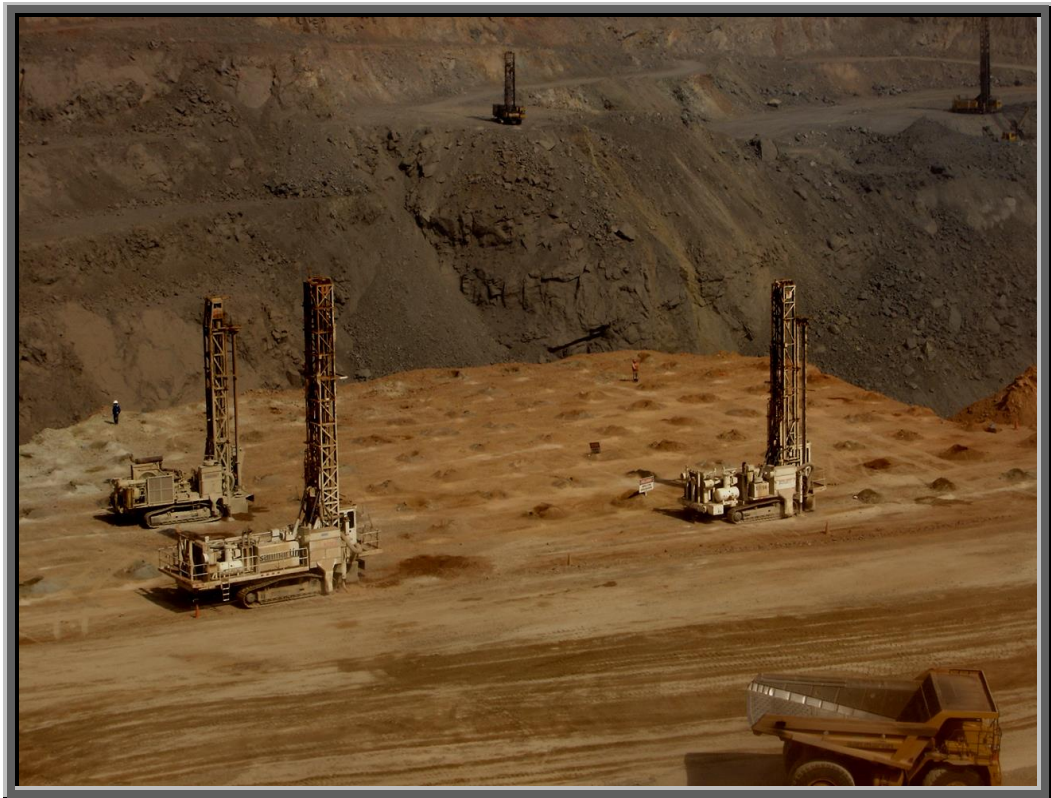
Proyecto de perforación primaria, Lado Norte Mina 4
