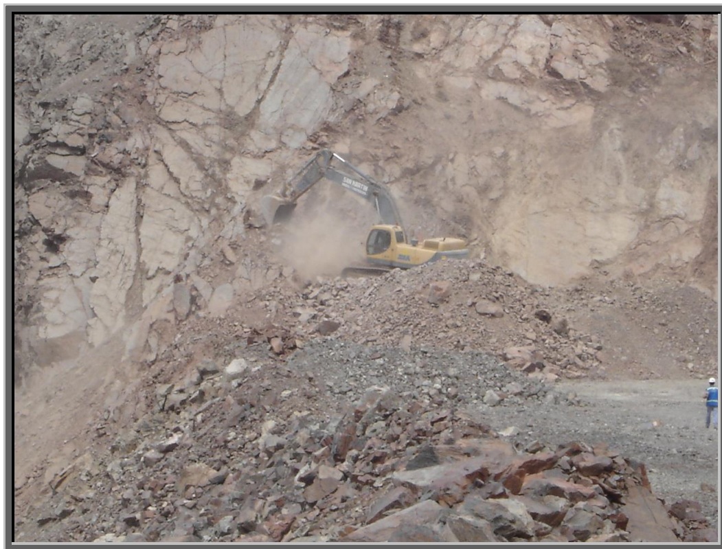
Trabajos de desquinche y perfilado en los frentes de trabajo
