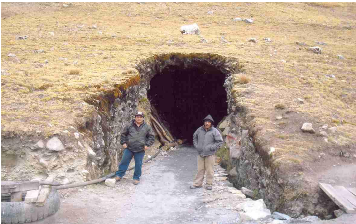
Nivel corte San Gregorio en plena inspección de trabajos
