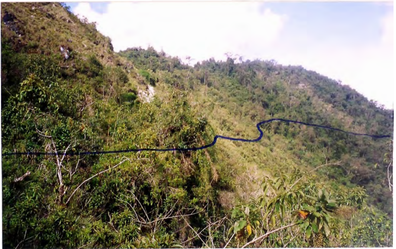
VISTA EN EL TRAMO PROGRESIVA 15+ 310 HASTA 15+ 940 DONDE ES NECESARIO REALIZAR MAYOR CORTE POR LO EMPINADO QUE ES EL TALUD
