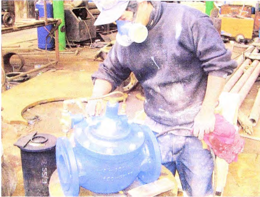
Figura 5.7 Proceso de pintado de una válvula de control, con esto mejoramos su propiedad ante la corrosión.
