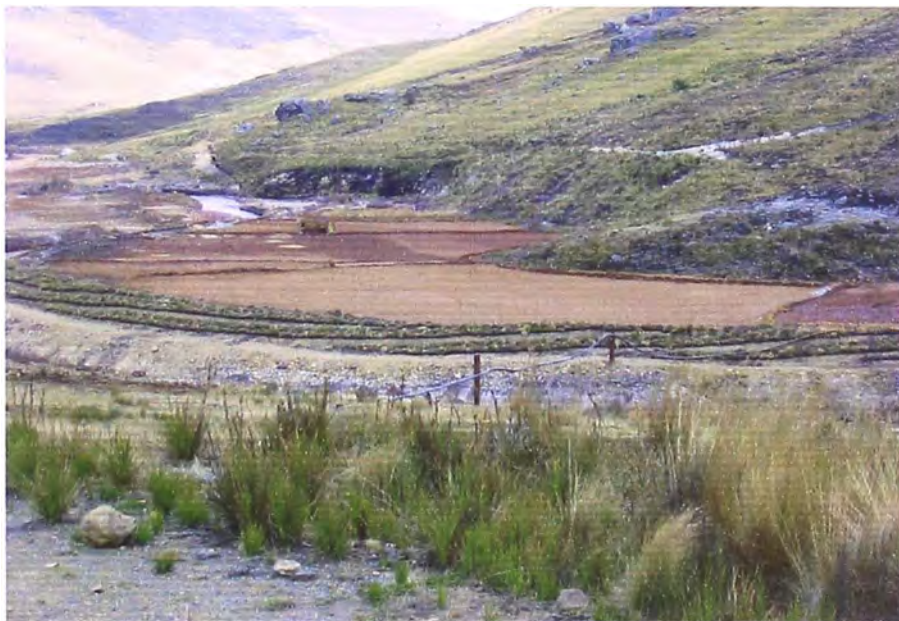
FIG No 10-2 Celdas totalmente recubiertas con lodos y revegetacion del talud
