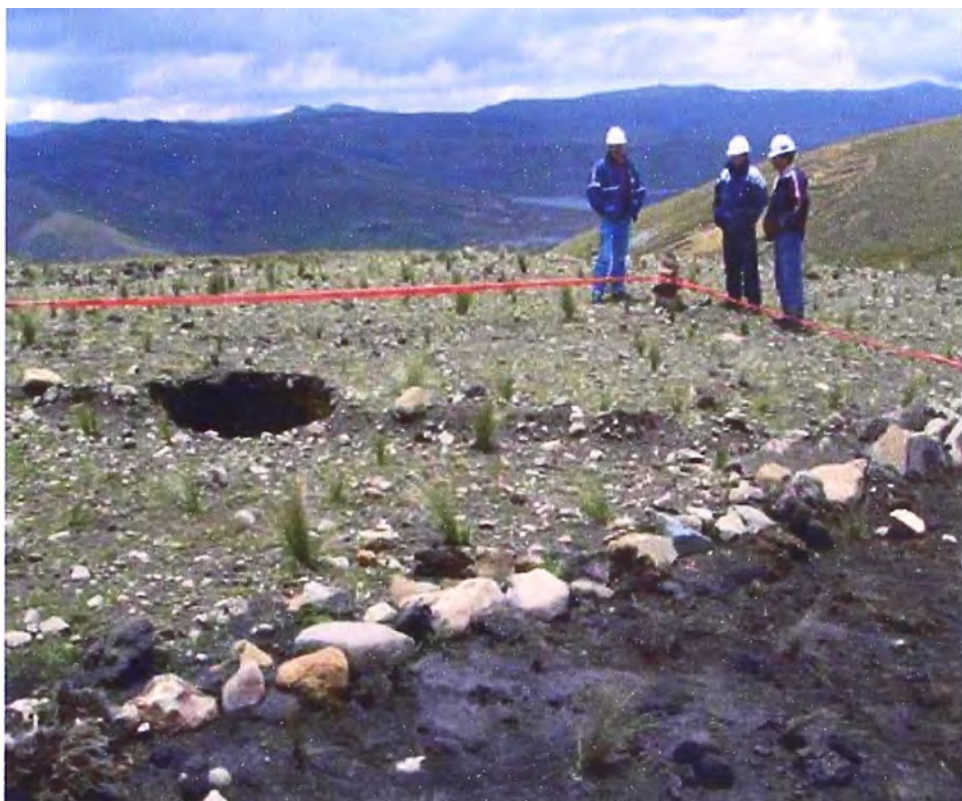
FIG No 5-3 Zona de hundimiento – Pique Almiranta
