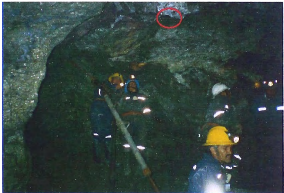
FIG No 10-8 ejemplo de riesgo en mina subterránea
