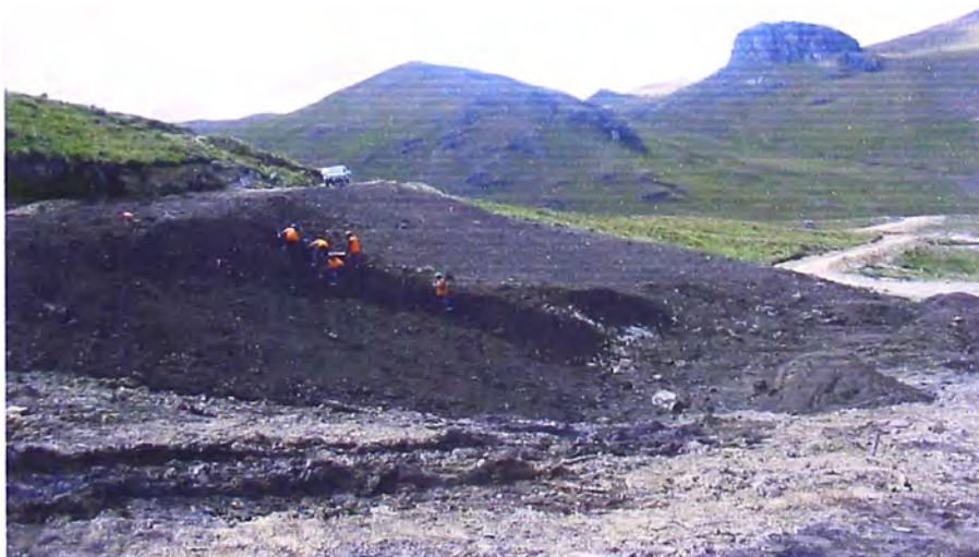
FIG No 10-4 Desmontes Zoila Gata (A la fecha)
