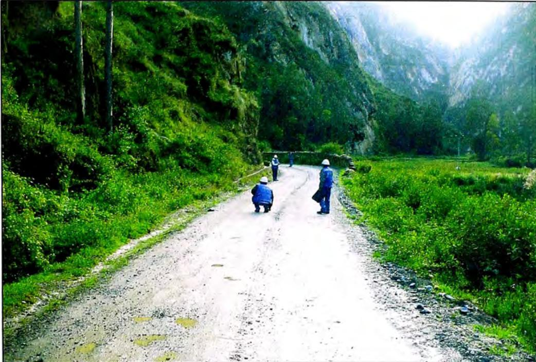
Vista panorámica del Tramo km 166+500 al km 166+800. Reconocimiento de campo, realizando un levantamiento topográfico con la finalidad de determinar el eje de diseño de la carretera.
