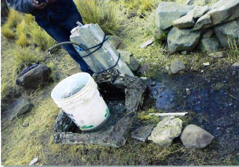
ESTADO DE LAS PILETAS
