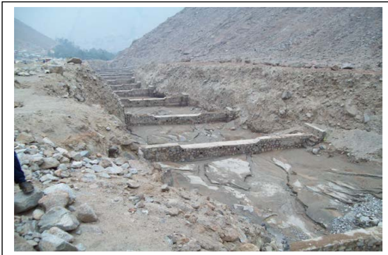
Quebrada la Ronda
